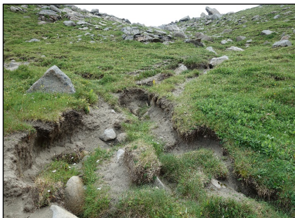
Vannerosjon i lågurteng som følge av tråkk som har slitt bort vegetasjonsdekket.
