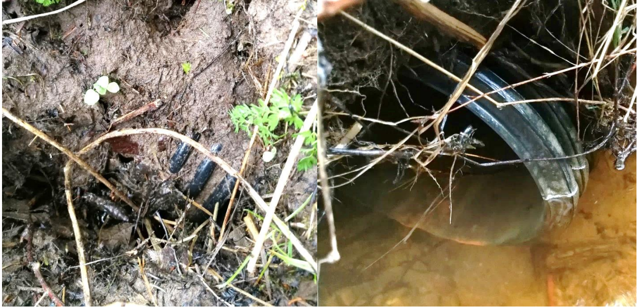
Figur 5: Dreneringsrør, det har luktet H_2S her ved alle prøvetakinger.
