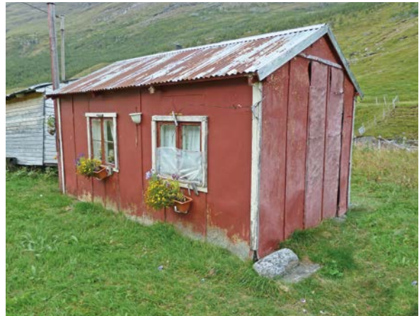
Etter krigen var det stor mangel på materialer, ikke minst i Finnmark og Nord-Troms, der tyskerne hadde brent ned det meste av bebyggelsen. Selet i Manndalen i Troms har vegger av tykk papp. Foto: Kari Stensgaard.
