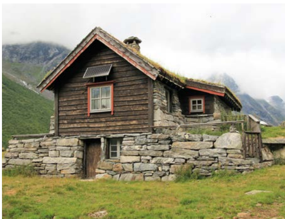
Sel har hatt ulike tilbygg; vedskåle, kokhus, mjølkebu eller fjøs. Etter avviklet setring får vi påbygg for fritidsbruk. Sel kan være såpass ombygd at den gamle husformen er vanskelig å kjenne igjen. Sogn og Fjordane. Foto: Kari Stensgaard.
