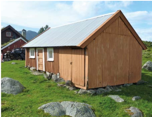
Gamle seterhus er ofte forsterket i ekstra værutsatte eller slitte partier. Trepanel, steinmur og steinheller er mye brukt. Her er en av veggene dekket av bølgeblekk. Forsand i Rogaland. Foto: Jan Reyer Elders.
