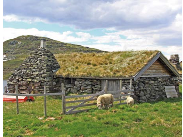
Stein er mye brukt i seterhus i høyereliggende områder, hovedsakelig i fundamenter og i uthus. I øvre Hallingdal finner vi stein også i selene. Her er litt tre i gavlen, ellers brede murer og karakteristisk stor vid skorstein. Ål i Buskerud. Foto: Kari Stensgaard.
