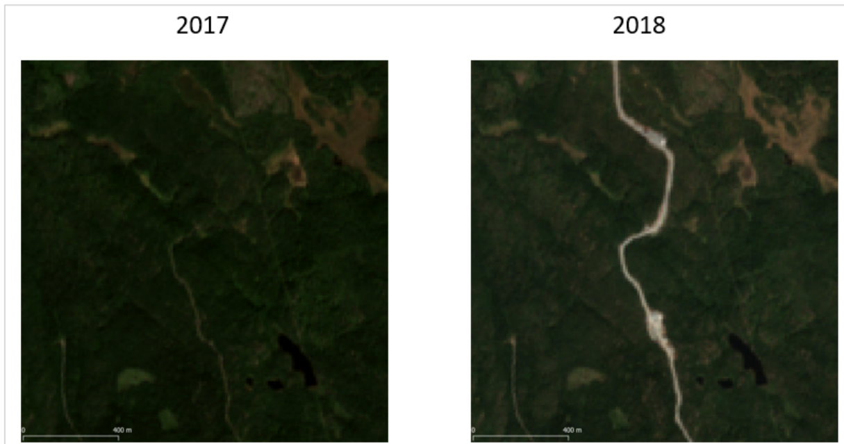
Figur 30. Anlegg av ny vei og fundament for nye vindmøller er tydelig i bildet fra 2018.
