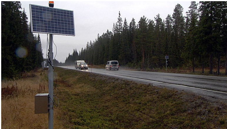
Figur 26. Interaktive eller “dynamiske” vilvarselskilt langs veien – varsellys til bilister ble utløst av vilt (for eksempel gjennom varmesøkende sensorer, til venstre et eksempel fra E6 i Nord-Trøndelag https://www.nrk.no/trondelag/unik-viltvarsler-pa-e6-1.8367905 ). Til høyre en modell fra firmaet Calonder i Sveits som bruker en kombinasjon av kamera og IR sensorer (bildet brukt med permisjon av Calonder Energy AS).
