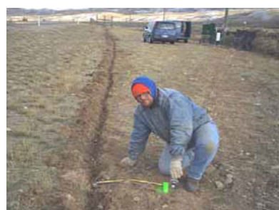
Figur 3. FLASH system med (v.t.h.) IR sensor langs veg, IR scope og geophones gravt ca. 10 cm ned i bakken i Nugget Canyon, USA (Fotos: WYDOT; bildet fra Huijser m.fl. 2005).
