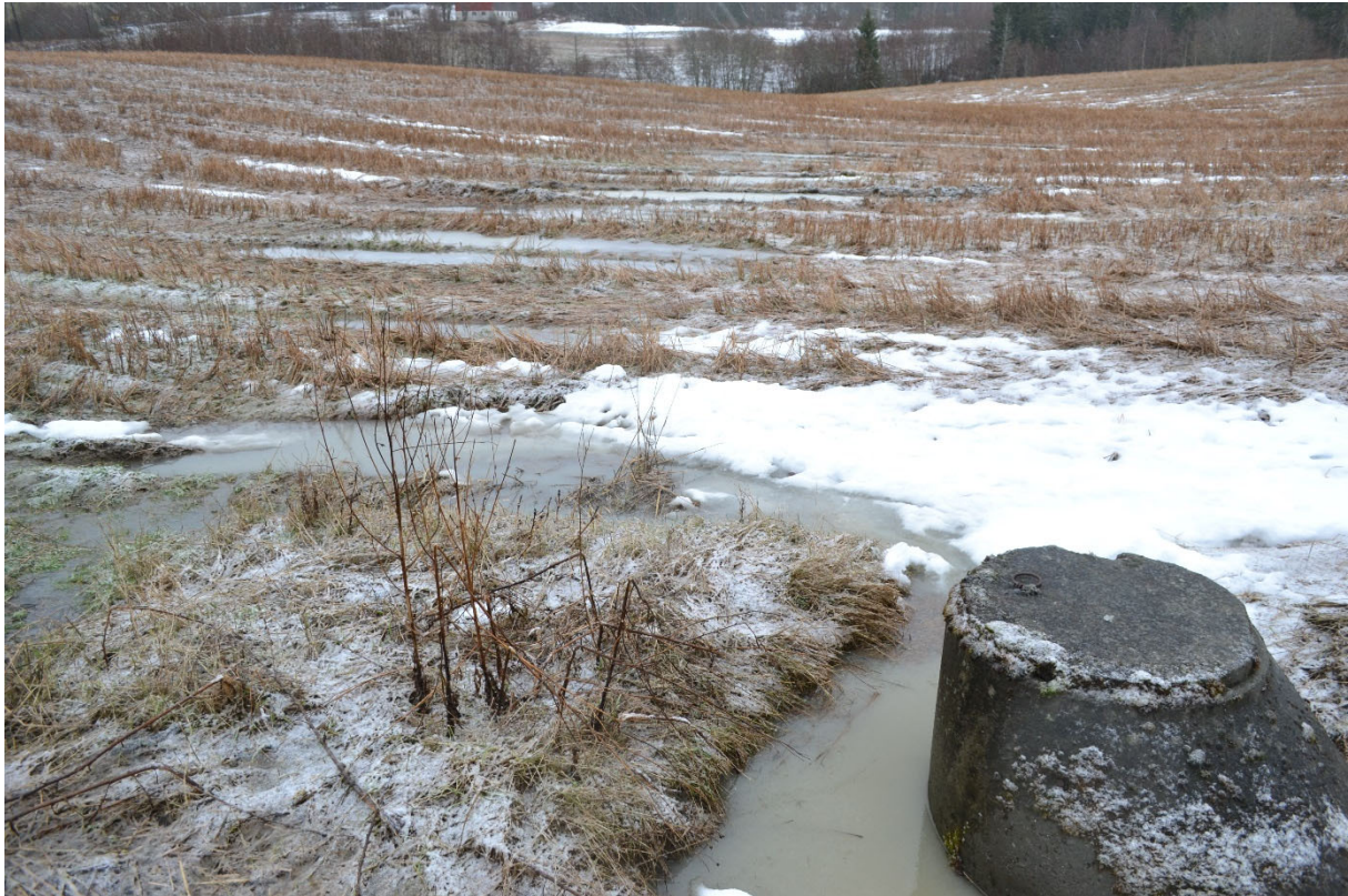
Figur 9: Drenskum langs lukket bekk gjennom tiltaksområdet. Vannet har gravd rundt kummen, og området rundt er svært vått på grunn av sviktende drenering. Foto: Trond Knapp Haraldsen.
