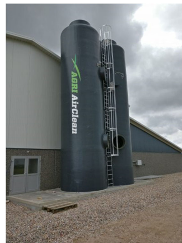
Figur 5.5. Luftrenser til svinefjøs. Kilde: https://agrifarm.dk/agri-airclean/#airclean
