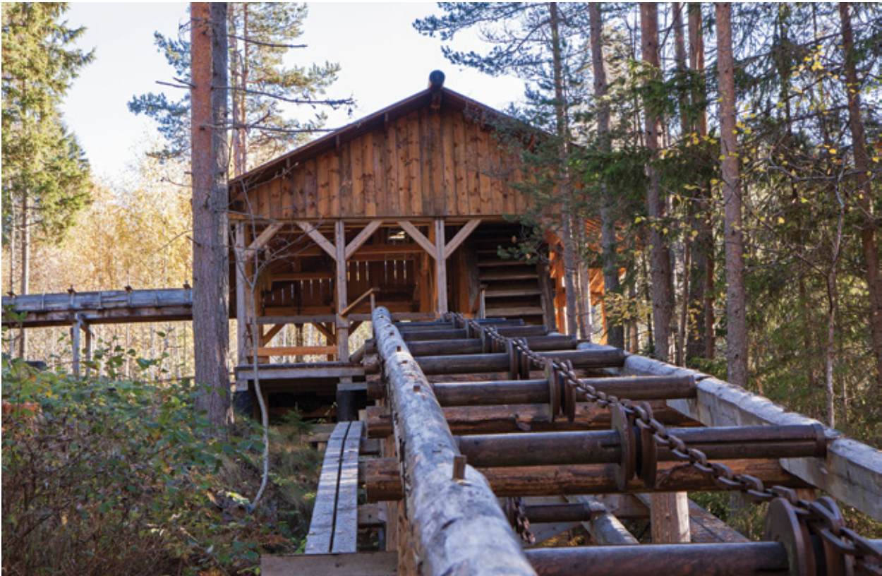
Over. Kjerraten i Åsa var i drift i 50 år, først på 1800-tallet. Den fraktet tømmer 400 høydemeter fra Steinsfjorden opp til Storflåtan for fløting videre ned til sagbruk i Lysakerelva. Bildet viser kjerrathus nr. 5 som er restaurert. Ringerike, Buskerud. Foto: John Y. Larsson, © Skog og landskap
