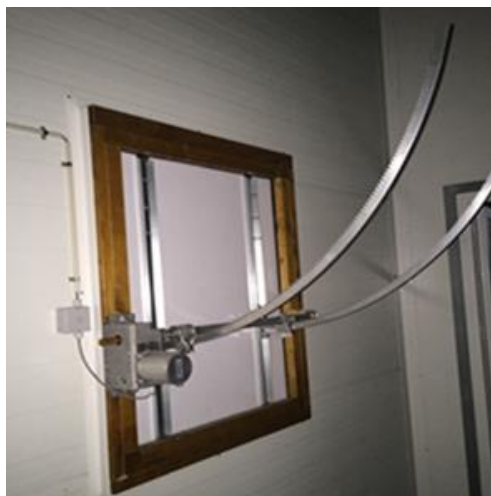
Figur 60. Automatisk spjeld for innslipp av uteluft
