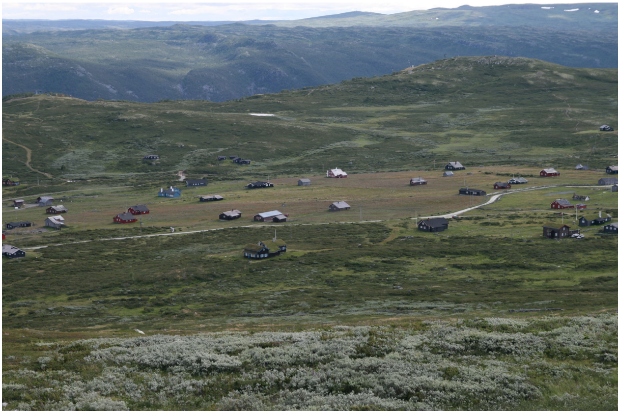
Bilde 10. Det bygges i nær tilknytning til og til dels på jordbruksareal. Mange bygg står derfor tett på dagens jordbruksareal, dette gjelder også for dette seterområdet fra Havsdaalen i Hol kommune i Buskerud.
