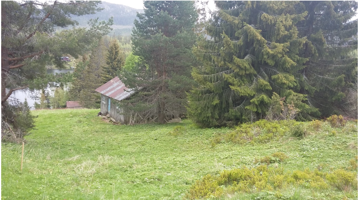
Figur 12. I dette området vil Mette Gunnes og Jon Ole Bekkhus sette opp hytte. Seterbua midt i bildet ble bygget i 1906 (jf Næss 1992) og er planlagt å skulle rives. Foto ES 27.05.2019.
