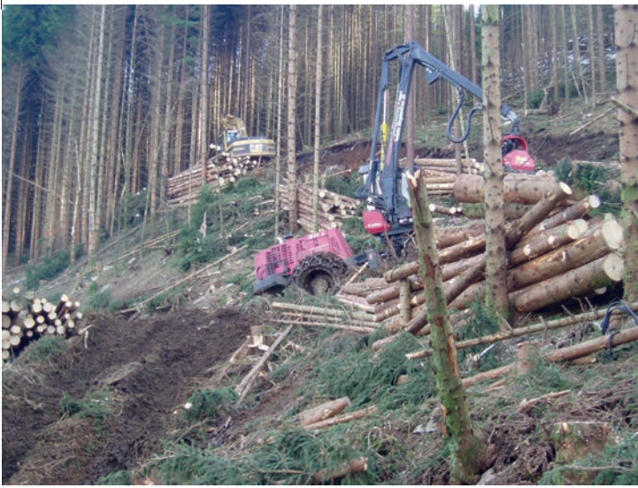
Graving av stikkvei i bratt terreng (Foto: Leif Kjølseten)
