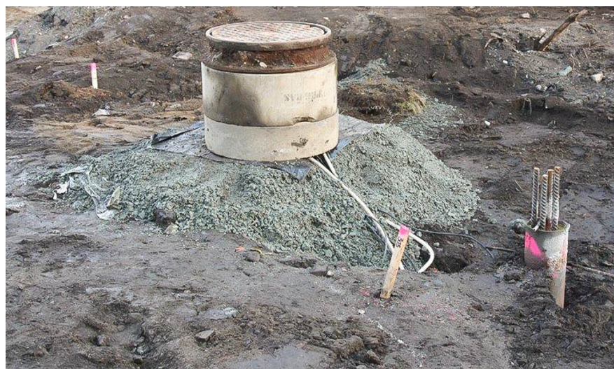
Figur 2. Tildekking av profil med Voltekst bentonitt duk i profil sør hvor miljøovervåkingsensorer er satt inn (over) og beskyttelse skum for midlertidig skap med logger og sender (under). (Foto Anna Petersén NIKU).
