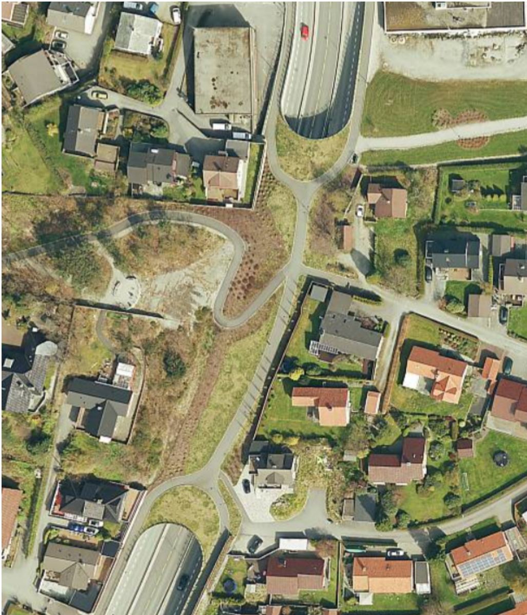
Figur 18. 120 m lang miljøkulvert over firefelts vei med reetablert parkdrag over kulverttak. (Foto: gulesider.no.)
