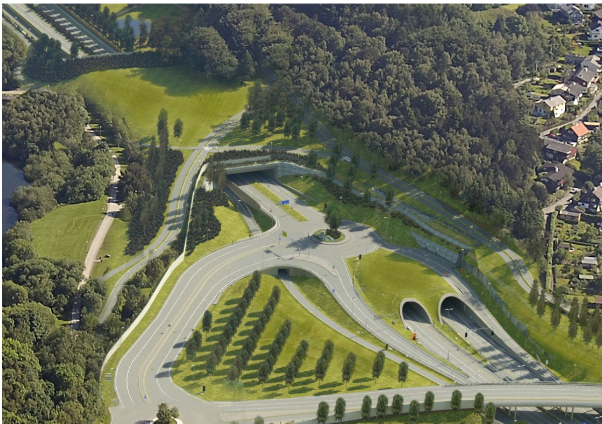
Figur 19. Fotomontasje som viser starten på Eiganestunnelen og avkjørsel mot Stavanger sentrum. (Foto: Vegvesen.no.)
