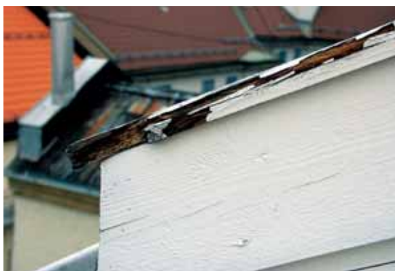
Vannbrett har kort levetid hvis det ikke er montert beslag. (Foto: Mycoteam as)
