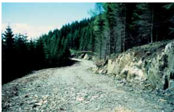
Bilde 2. Kombinerte veger for skogbruk og friluftsliv har vist seg å være en god løsning i bynære skogområder. Bildet viser en kombinert bilveg under anlegg i bratt terreng, der terrengforholdene setter klare begrensninger for vegens utforming. Frotveit-Riple, Bergen. Foto: Hans Nyeggen
