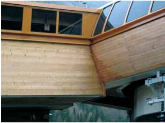
Bilde 3 Varmebehandlet tre benyttet i skianlegg i Chamonix, Frankrike. (Foto: Lone R. Gobakken)
