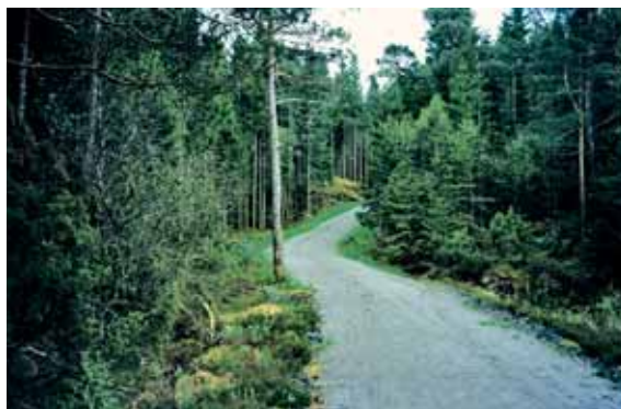
Bilde 1. Mange brukergrupper innen friluftsliv er avhengig av eller begünstiget av skogsveger. Bildet viser en vellykket tilpasning av bilvegen til landskap og friluftsliv. Vegkroppen er anlagt på en underbygning av flis. Hordnes, Bergen. Foto: Hans Nyeggen
