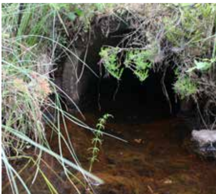
Bilde 9: Kulvert i Guriputtbekken. Merket V1 på kartet.
