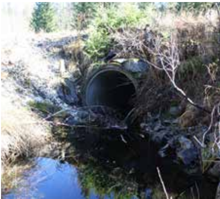
Bilde 22 og 23: Kulverten under veien er ikke ett vandringshinder (V1.).
