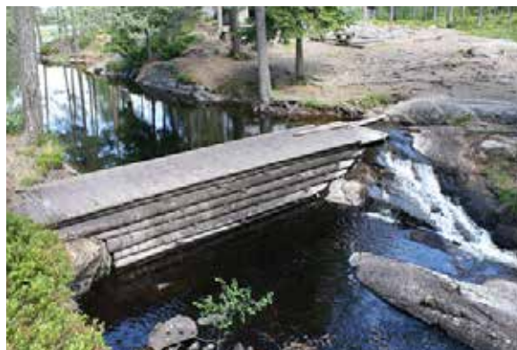
Bilde 18 og 19: De to steinkistedammene ved det vestre utløpet til Gjerdrumsgjermeningen, merket V1 og V2 på kartet.
