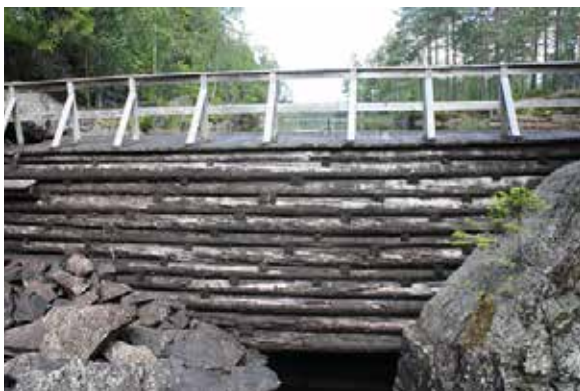
Bilde 18 og 19: De to steinkistedammene ved det vestre utløpet til Gjerdrumsgjermeningen, merket V1 og V2 på kartet.
