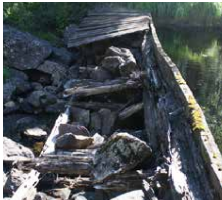
Bilde 14, 15 og 16: Steinkistedemningen før restaurering høsten 2017, merket V1 på kartet, og fritt sideløp markert med sort strek på kartet.
