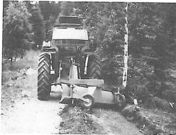
Fig. 23. Kanthøvling, traktorskjær. (Foto: H. Western) Rehabilitation of road edge with grading blade.
