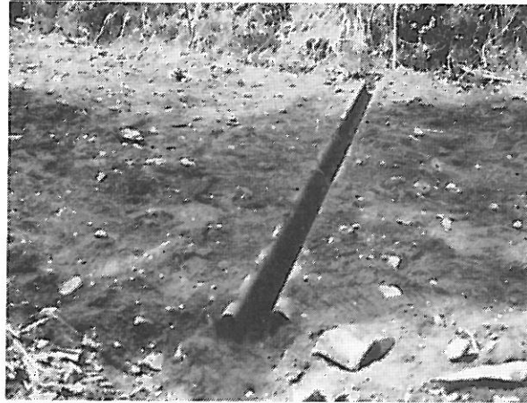
Fig. 22. Nylagt overflaterenne (Foto: R. Skaar) Newly installed open top culvert
