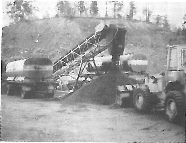
Fig. 20. Produksjon av emulsjonsgrus (Foto: R. Skaar) Production of emulsion gravel
