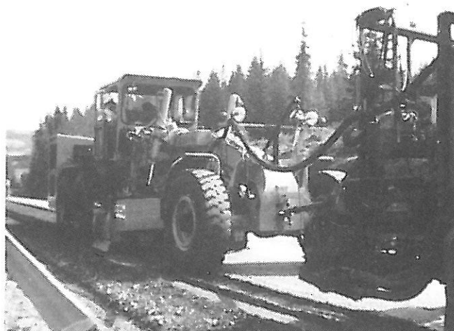
Fig. 21. Overflatestabilisering med spesialfres (Foto: R. Skaar) Stabilisation of surface with rotavator
