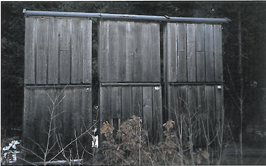
BILDE 3: Prøvevegger av ubehandlet ospekledning ved Agder Tresenter. Foto: Per Otto Flæte
