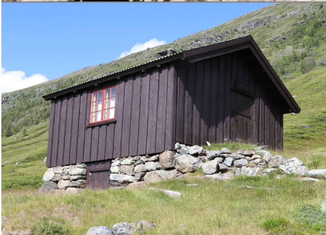
Karstugua på Helle var opprinnelig setras eldhus. Ei aurbu med kjellerrom bygd delvis inn i bakken. I seinere tid har huset fått nytt tak og mer panel. Karstugu er lokal betegnelse på hus som ble brukt til overnatting for arbeidshjelp. Foto Arthur Sand i 1969 og Oskar Puschmann i 2019.
