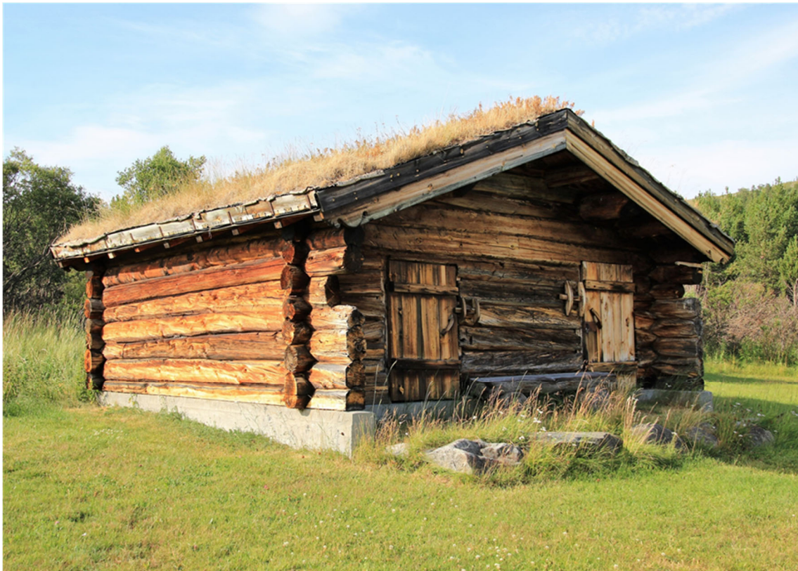
På Austrem har stallen fått en ny plass på tunet, og den har fått solide fundamenter å stå på. Foto Kari Stensgaard 2019.
