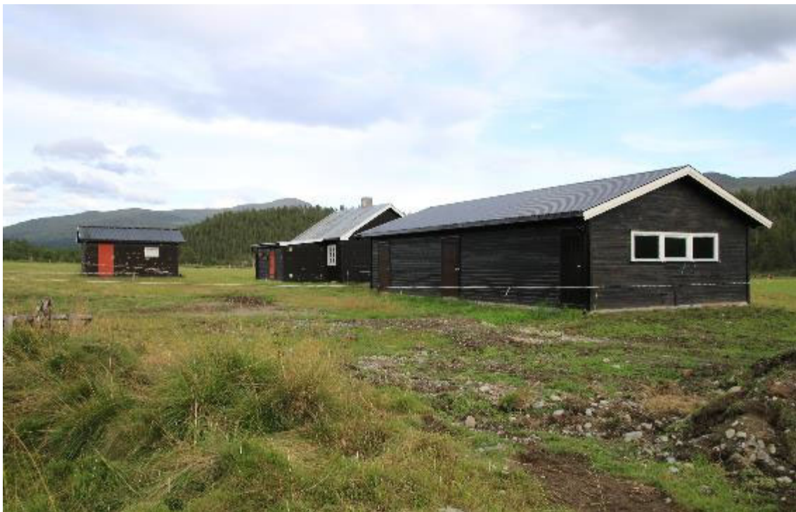
På nysetra Løken kom det opp nytt fjøs i 2019, på plassen etter det gamle som var slitt og måtte rives. Fjøset er til bruk for høstbære kyr, og det er ikke planer om melking i setersesongen. Foto Kari Stensgaard 2019.
