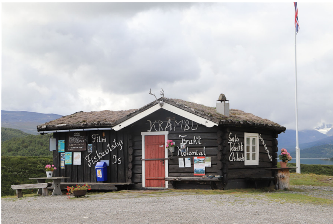
Den gamle krambua er et kjært kjennemerke i Sjødalen. Med lang avstand til bygda var det godt med ei bu som kunne forsyne folk med det mest nødvendige. I disse dager får krambua selskap av et kafébygg som er under bygging. Foto Oskar Pusmann 2019.
