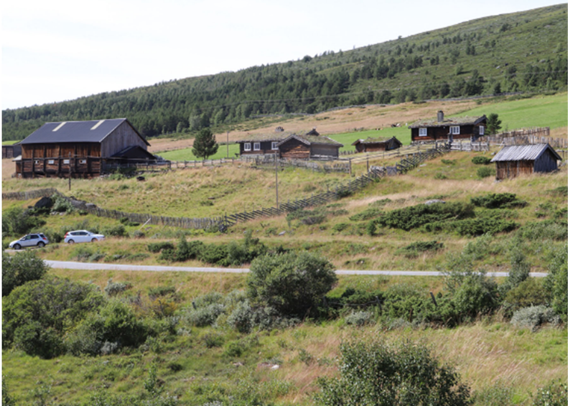
På Lundesetra ble melkeproduksjonen tatt opp igjen på 1990-tallet. Fjøset ble rustet opp og det ble gjort flere endringer i bygningsmassen. Spontaket på driftsbygningen ble erstattet av bølgeblikk mens andre hus fikk tilbake never og torv. Vegetasjonen vokser opp igjen på de tidligere snaugnagde områdene inntil setra. Foto Arthur Sand i 1969 og Oskar Puschmann i 2019.
