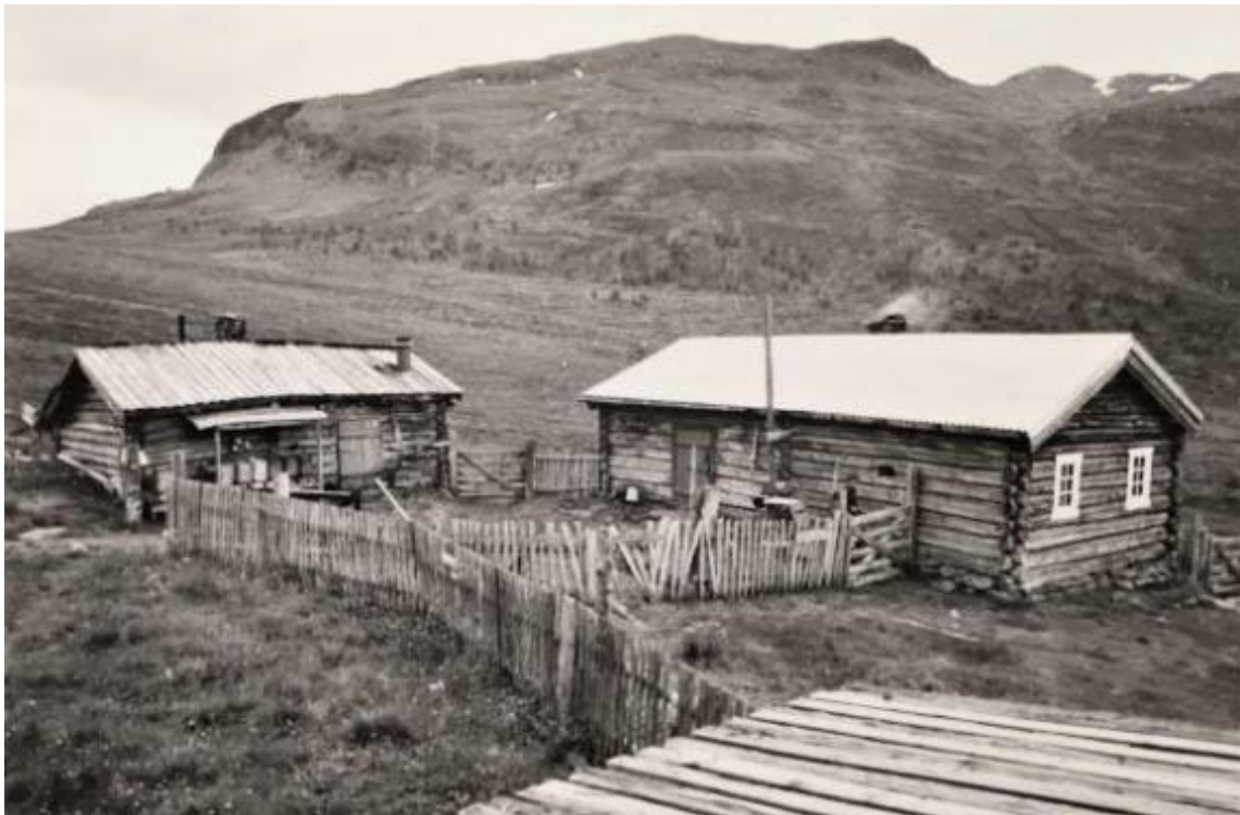
På flere av setrene brukes en eldre og mindre stue til eldhus. Som her, på Kampeetra i 1969. 50 år etter har begge hus fått panel med rødbrun farge og noen flere vinduer. Eldhuset har fått rettet opp skjeve vegger, og har fått torvtak. Bildet er tatt fra taket på geitfjøsset. Foto Arthur Sand i 1969.
