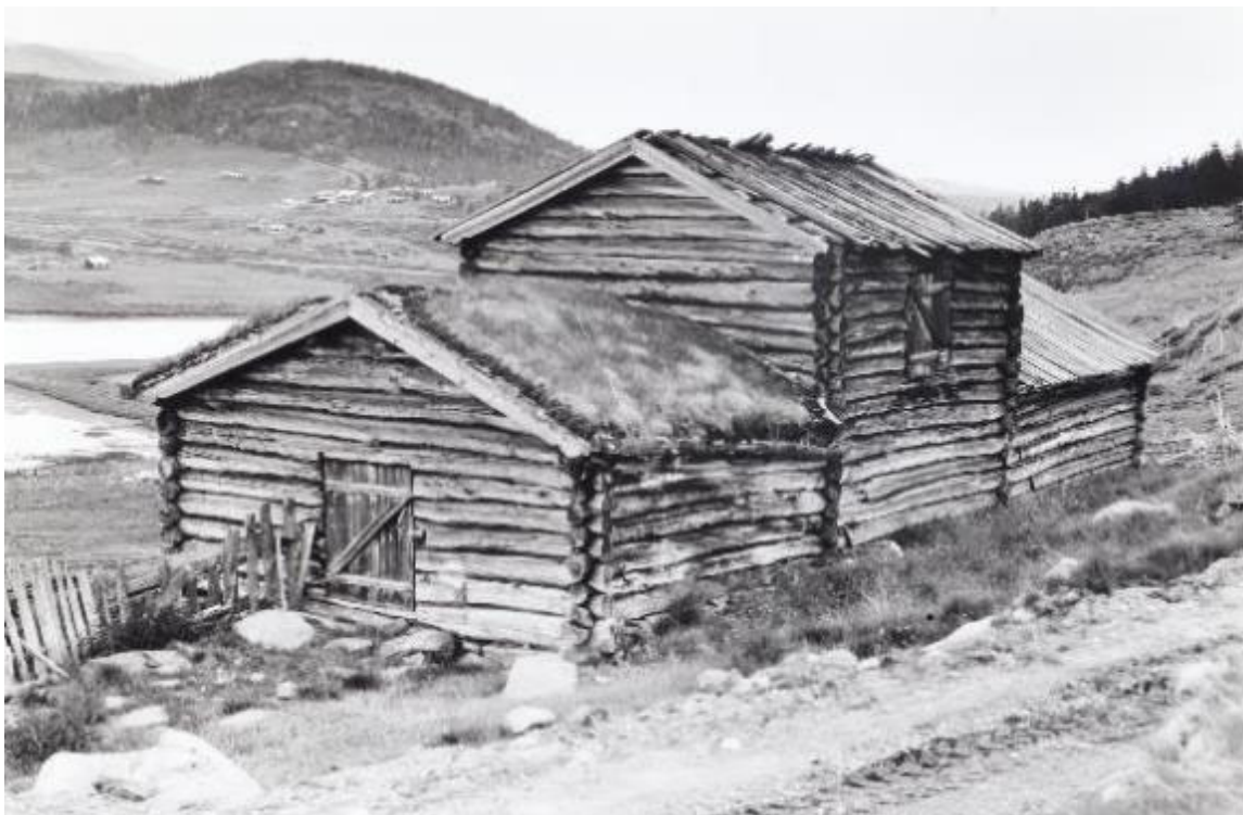
Dette trevfjøsset sto på Stuttgongen i 1969, men er siden revet. Brua opp til trevet er her fjernet. På trevet lå laven (måsån) til tørk før den ble skyflet ned til dyra i fjøsset. Små glugger i hver avdeling gir lys inn, i tillegg til dørene i hver ende av huset. Alle tak er røstet samme vei. Det står tre slike fjøs igjen i området «vårt». Et stort trevfjøs med fire rom, som før sto på Valbjørsetra, står nå på Maihaugen. Foto Arthur Sand i 1969.
