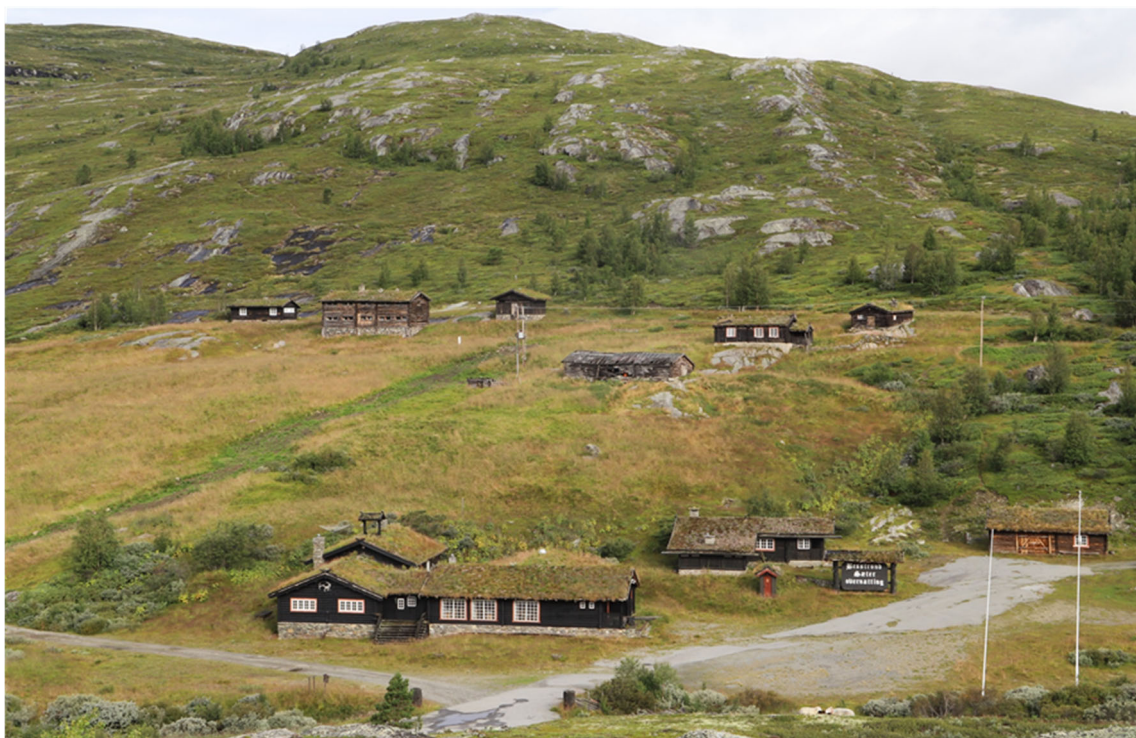
Setra på Storrviksbesstrond står til forfalls. Nedenfor setertunet, nær veien, ble det bygd opp et turistanlegg med tilbud om mat og overnatting på 1970-tallet. Flere av seterhusene ble bygd om til gjestehus. Nå er også denne drifta avviklet. Foto Oskar Puschmann 2019.
