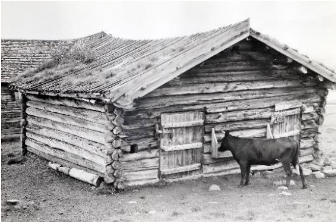
Stallen på Fellese har hatt plass til fem hester. Døra til høyre er inn til hestene. Den til venstre er inn til fôrgangen, der det også er plass til seletøy og utstyr. Huset er i bedre forfatning i 2019 enn det var i 1969. Foto Arthur Sand i 1969.
