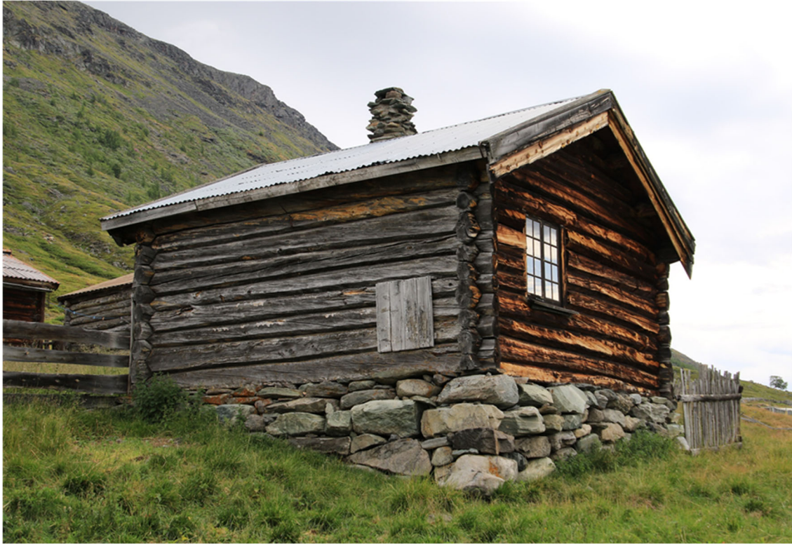
Hva skal man bruke gamle hus til når opprinnelig funksjon har opphørt? Stallen på Helle er bygd om til hytte. Møkkkluka er plugget igjen og huset har fått ildsted og pipe, og et vindu ut mot dalen. Foto Kari Stensgaard 2019.
