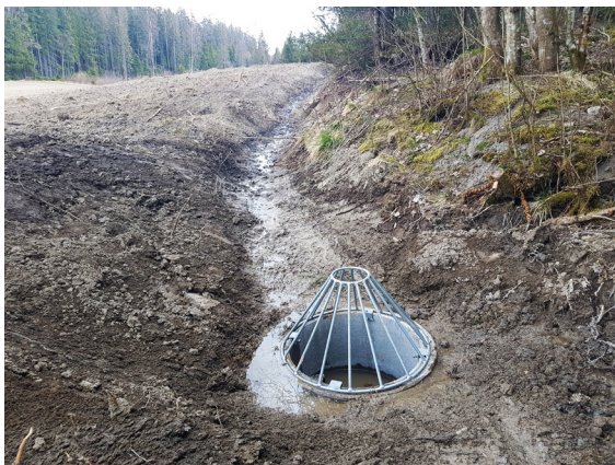
Nedløpskum og åpen avskjæringsgrøft mellom åker og skog. Foto: I. Tenge, NIBIO
