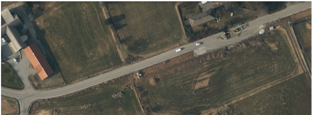
Figur 12: Bilde frå 2018 viser at bygging av gang- og sykkelvegen pågår.
