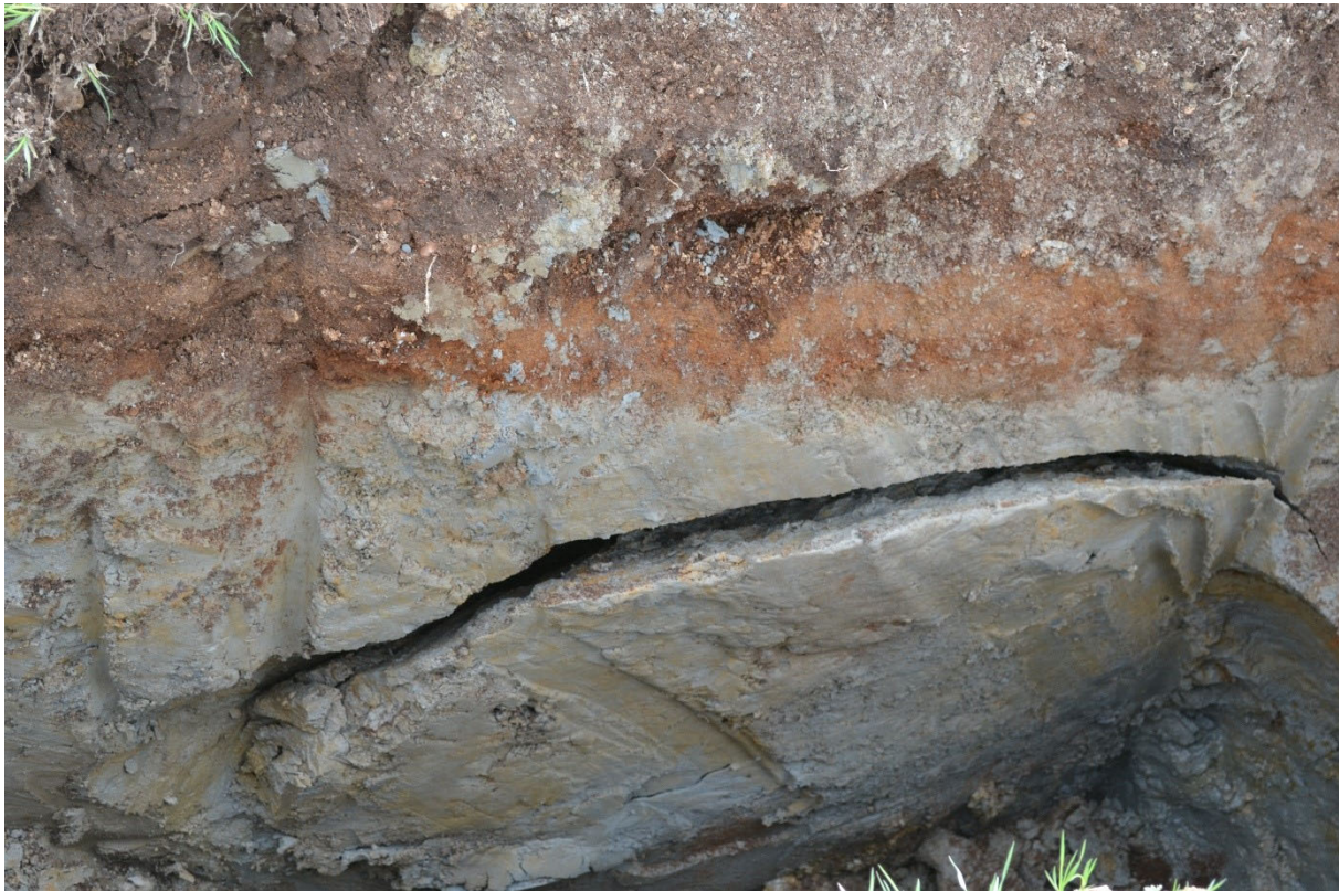
Figur 1: Ustabile masser i et jordprofil gravd ut på et område omdisponert til gravplassutbygging. De grå massene besto av siltig finsand og var svært skjøre, med lite klebrige egenskaper. Profilveggen kollapset kort tid etter at bildet ble tatt. Foto: Trond Knapp Haraldsen.
