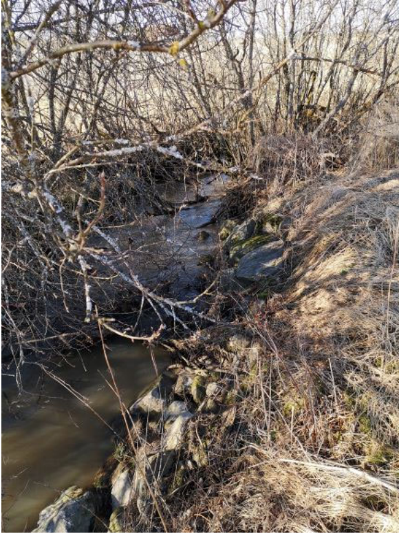
#11 Eksisterende terskel som ikke er erosjonssikker
