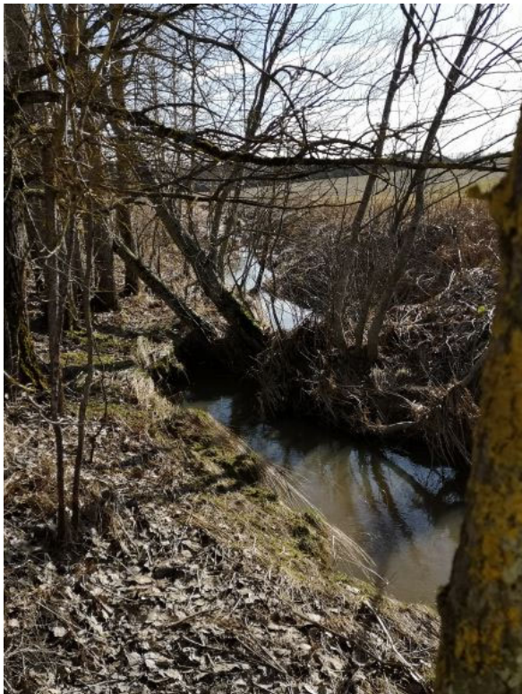
#19-21 Meandrering, erosjon i yttersving og trær som luter.
