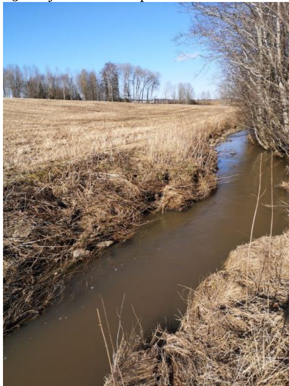
#3 Erosjon i bekkeside på vestsiden.
