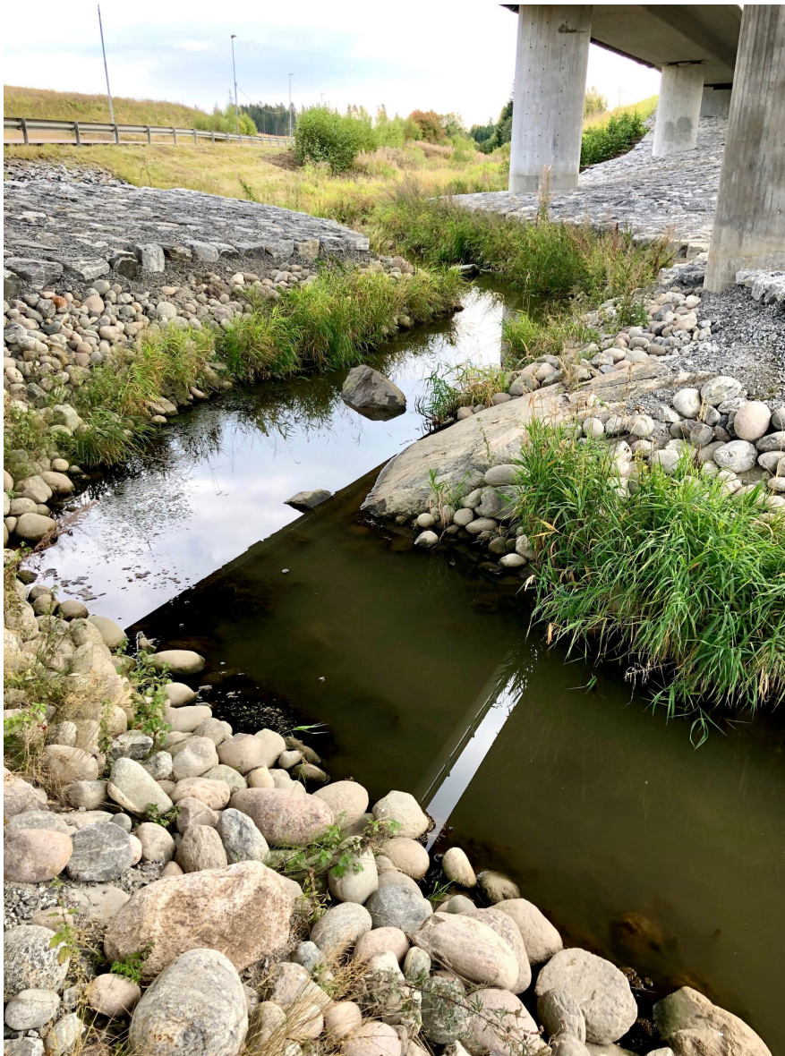
Figur 3. Fossbekken ved den restaurerte delen under E18.
