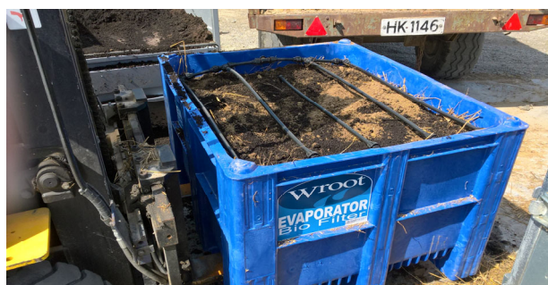
Figur 13. Filterkasset med dryppvanning for å fordele vannet. (Foto: B.K. Snapa).
