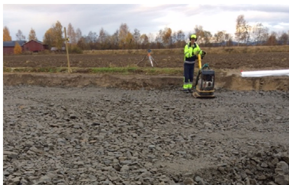
Figur 6. Utskifting av jorda på området med pukk. (Foto: B.K. Snapa)
