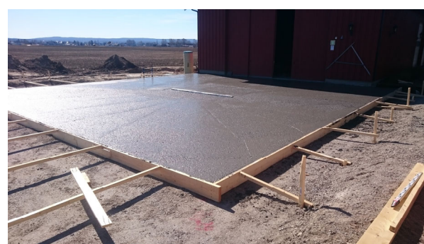
Figur 9. Støping av ei 10 cm tykk armert plate med sluk for drenering til oppsamlingstanken i figure 7. (Foto: B.K. Snapa)
