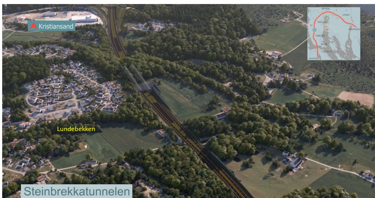
Figur 2.12. Illustrerer ny E18 i området nord for Steinbrekkatunnelen, et område som har avrenning til Lundebekken.
