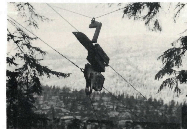
Fig. 83. Iglands løpekatt for fast heiseline med løpevogn til passering av bæresko for løpende bærekabel.
