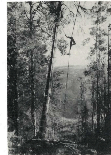
Fig. 38. Monteringsstige i fingerbukk. Kviteseid 1978.
