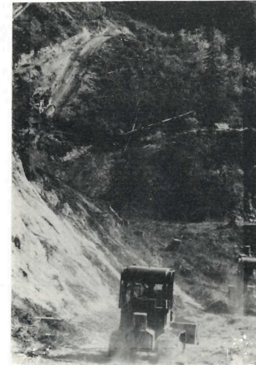
Fig. 13. En International TD-8 nedover med lass, og en på retur til skogs.
