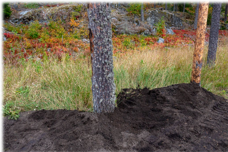
Figur 2. To nye døde trær ble observert i kantsonen til deponiets nyere del i 2021. Det ble ikke påvist sprekker rundt disse trærne. Tiltak blir utført av ROAF med fjerning av trær og tildekking med kompost (under).
