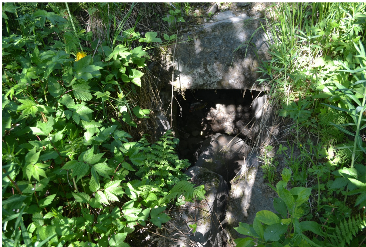
Figur 17. Stikkrenne under Fv. 213 ved Roverud.
