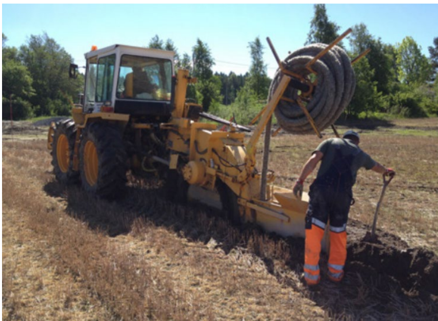
Figur 2. Grøfting med Rådahlshjul. Grøfting under gode, tørre forhold gir best resultat. (Bilde: Atle Hauge)
