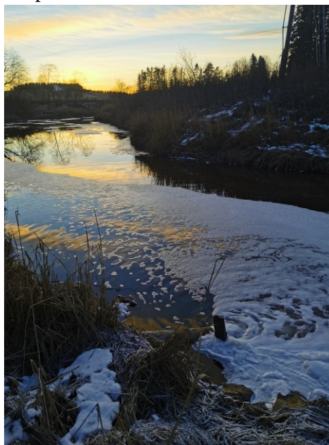
Figur 20. Utslippspunktet fra Hølandselva RA. Røret står midt i bilde nede. Prøven er tatt ca. 0,5 m fra dette punktet.
