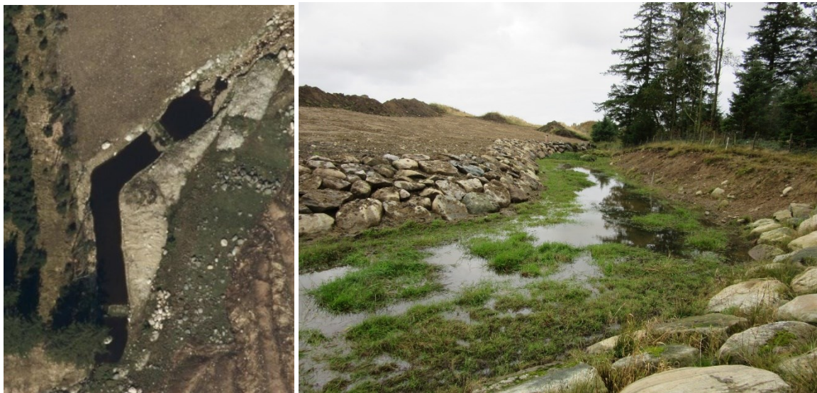
Figur 5. Renspark 2, som i løpet av sommeren 2021 ble ombygd med steinsetting, og hvor matjorda er lagt i hauger. Bilde tatt nedover mot utløp. Bildet er tatt i september og da var ikke matjorda lagt tilbake. (Satellittbilde fra finn.no; foto Eva Skarbøvik)
