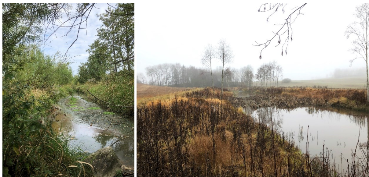
Figur 53. Til venstre: Fangdam på Østlandet som er fylt opp med sedimenter, det er dannet snikstrømmer og fangdammens areal blir ikke benyttet optimalt. Det er behov for å fjerne sedimenter fra denne fangdammen. Til høyre: Det er nylig fjernet sedimenter fra denne fangdammen. Det står igjen «striper» med vegetasjon som vil spre seg til resterende areal i våtmarksfiltrene.
