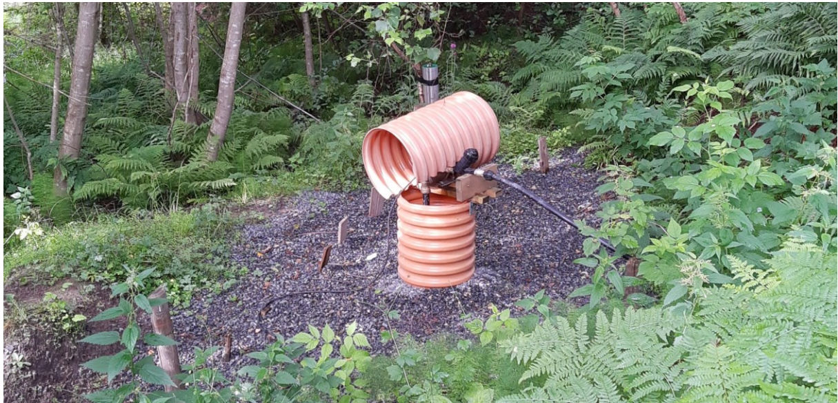
Figur 21. Gruskastet kum etablert for vanning av bringebær på Knipkil gård (Foto: Charles H. Carr).
