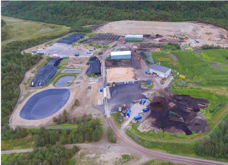
Figur 2b. Dronefoto over anlegget til ORIGO SKIBOTN juni 2018 med ferdig nytt deponi og sivevannsdam. (Foto Origo Skibotn)
