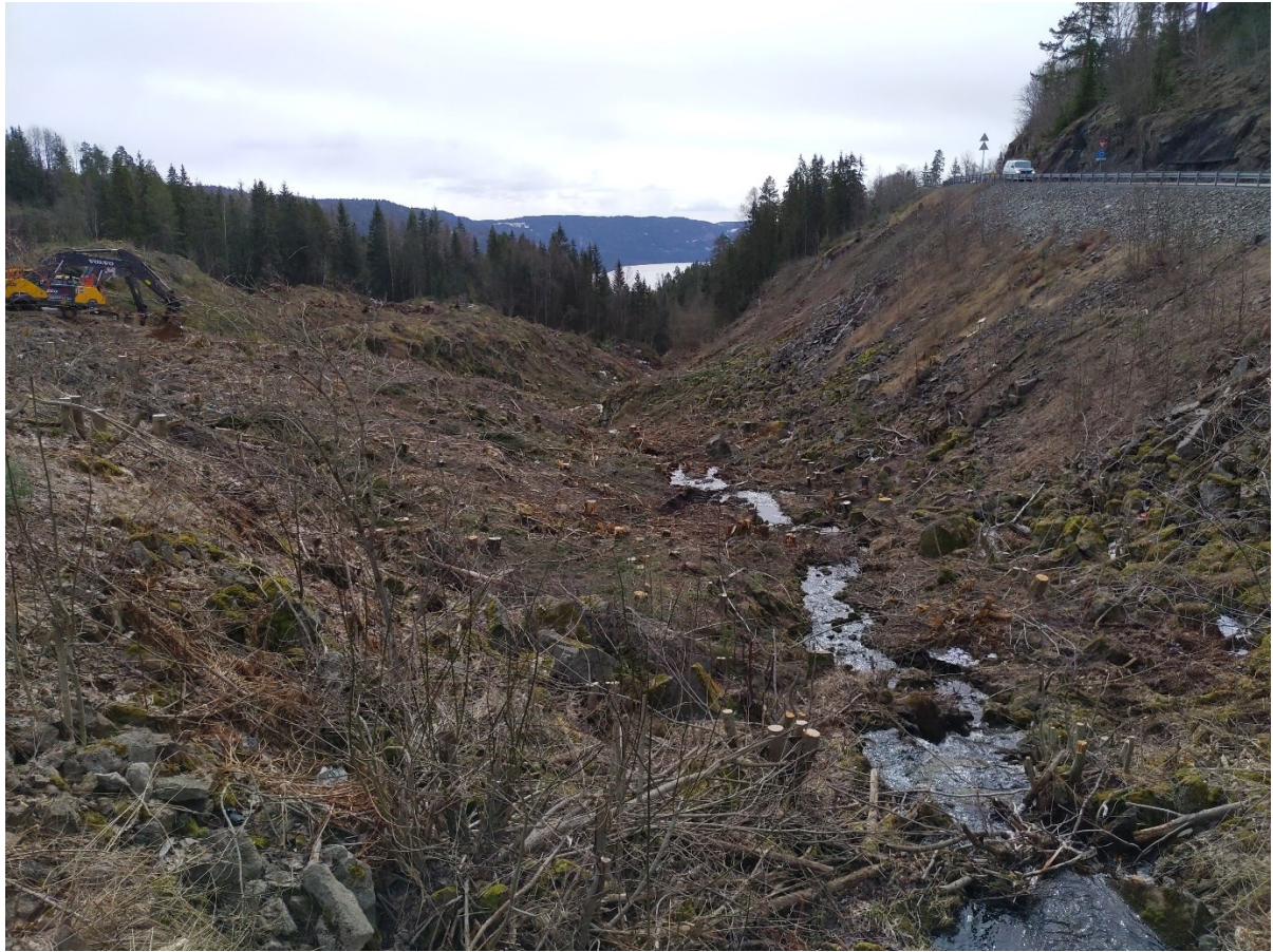
Nordlandsbekken øverst i Nordlandsdalen før den ble lagt i rør. Dato: 07.04.21.
