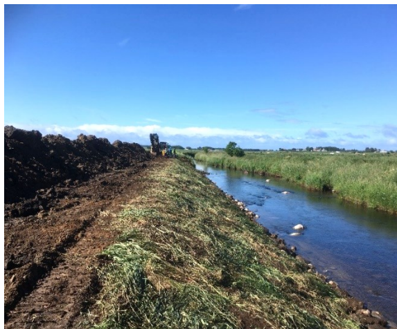
Restaurering av kantsoner. Kantene gjøres slakere med gravemaskin og steinsettes nederst
