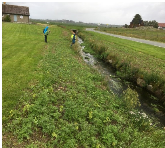
Steinsatt kantsoner med nyetablert blomstereng
