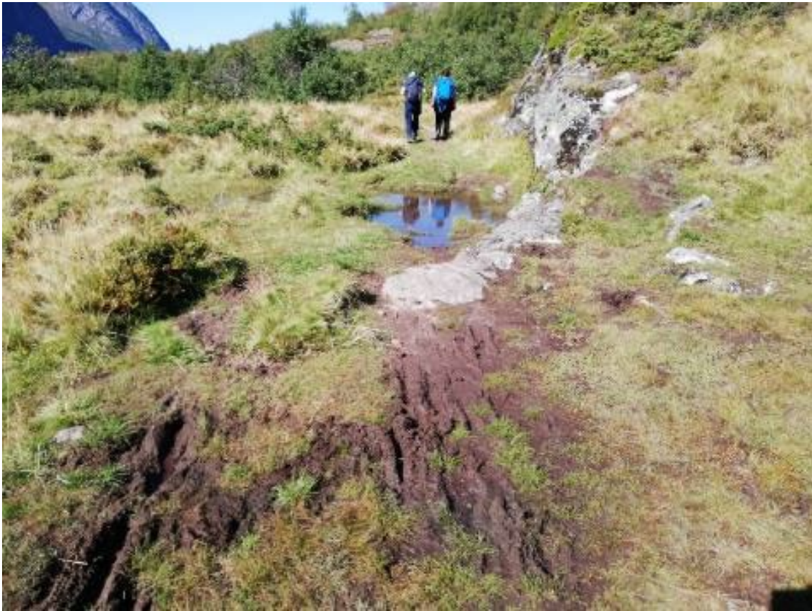
Figur 8.4.3. Dette partiet av buføringsvegen ved Erdalssetra er svært blautt og treng avbøtande tiltak raskt. I dette området er det også naudsynt med eit sperregjerde. Foto: Bolette Bele/NIBIO.
