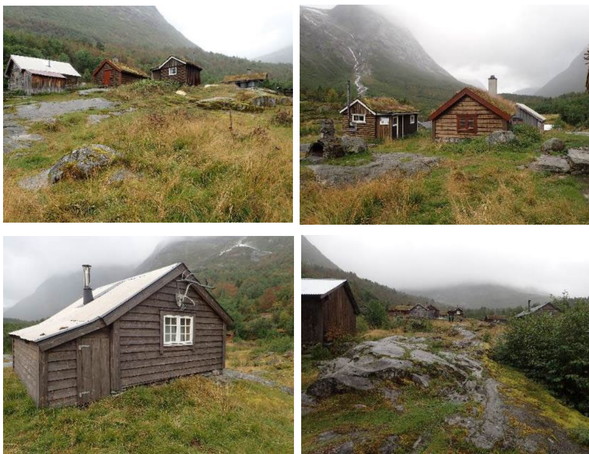
Figur 6.7.1. Dei mange bygningane ved Sunndalssetra er i god stand. Foto: Sjønnøve Nordal Grenne/NIBIO.
