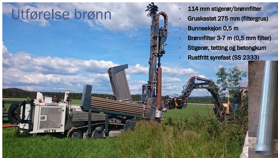
Figur 8. Etablering av ny brønn for overvåking på Haslemoen i Våler kommune.
