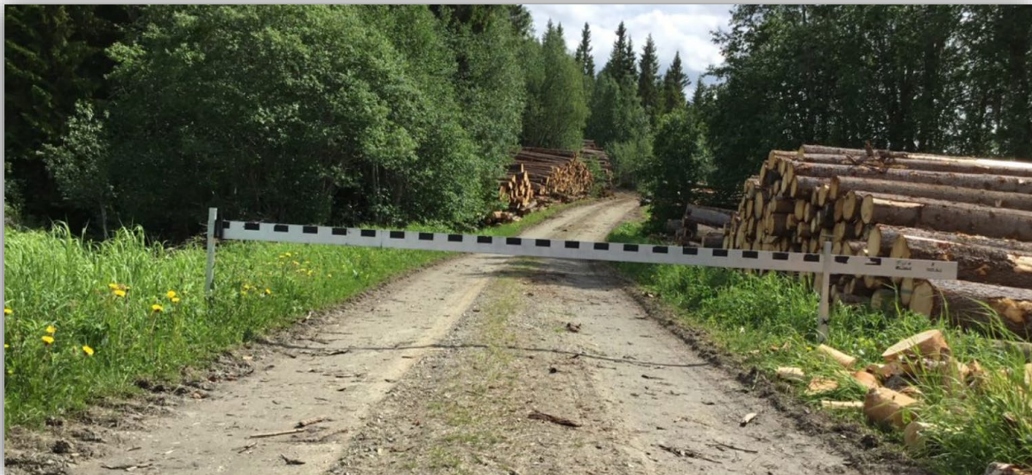
Bilde 8: Skogsbilveiene er avgjørende for skogbrukets lønnsomhet. Dessverre er mange veier, i sin tid, bygd opp av stedeegne masser for transport med kortere og lettere tømmerbiler, samt for et annet klima. Bæreevneprosjektet skal hjelpe planleggingen av fremtidens drifter for å prøve å unngå ødeleggelse av veier ved feil bruk (bruk til feil tid). Foto: Martin Bråthen
