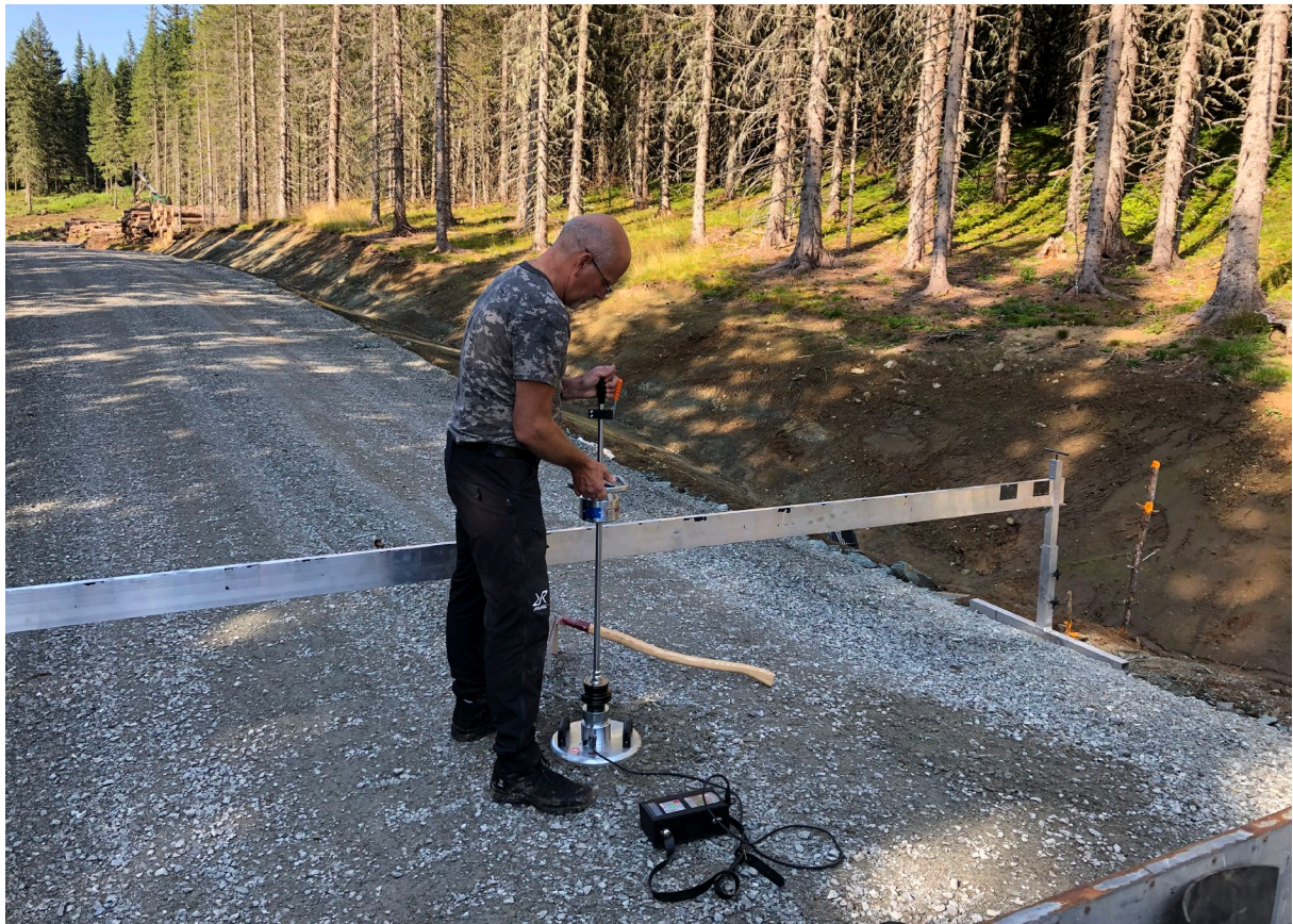
Bilde 3: Bæreevne måling utført av veiplanlegger Bjørn Arve Øvereng på en nybygd vei. En solid og fint utformet vei. Foto: Martin Bråthen.
