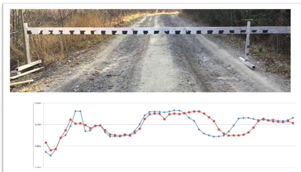
Bilde 5: Det ble benyttet en 5 meter lang skinne og distanselaser til å lage en overflateprofil av veien. På bildet vises resultatene for et par tester på en vei med store sporskader. Foto: Martin Bråthen
