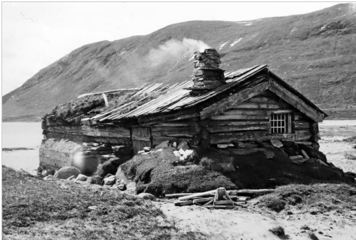
Bilde 38. 1970. Naustene ved Nordseter måtte flyttes eller rives da vannet skulle reguleres. Ett hus ble reddet. Båthuset til Frisvoldsetra var mer robust enn de andre, dels bygget i stein, men tilstanden var skrøpelig. I tillegg til rom for båt og garn har huset et lite rom med ildsted og plass for seng og bord. Foto Arthur Sand,UiO.
