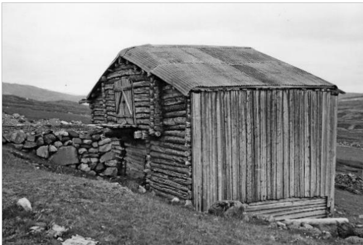
Bilde 17. 1970. De fleste løene ved Tesse skal være påbygd. Den store løa til Enersvold i Smørlia er påbygd med utgangspunkt i en ettroms og enetasjes tømmerløe. Foto Arthur Sand, UiO.
