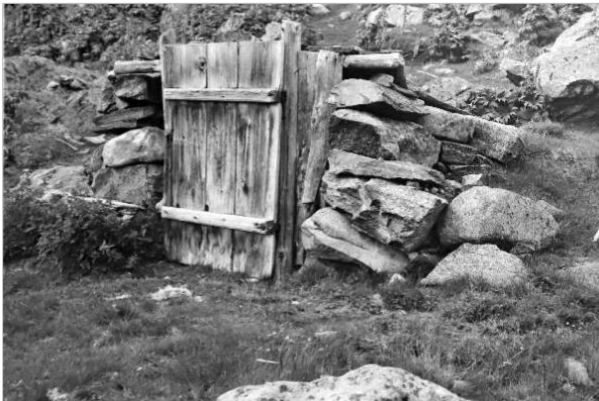
Bilde 36. 1970. Med oppmurt stein, en tredør og noen planker på taket, ble det rom for et par griser. Kan dette ha vært avkjøling for melkeprodukter i eldre tid? Enersvolds seter i Smørlia. Foto Arthur Sand, UiO.
