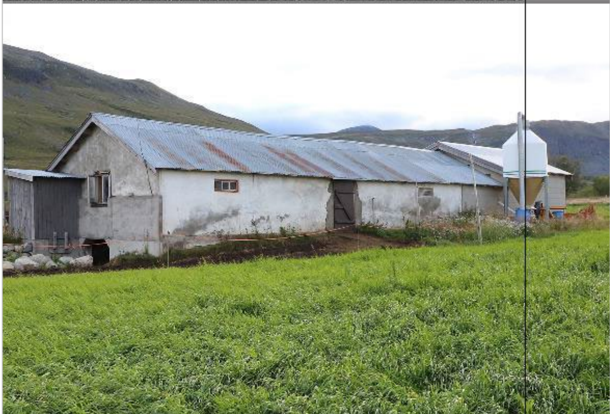
Bilde 58. 1970 - 2020. På fire setre sto det mura fjøs i 1970. Fjøset på Lyngvedøygard har vært i kontinuerlig bruk siden dengang. Bygningen er utvidet med fjøskjøkken eller tankrom, båsene er blitt færre og større, og inngangene er flyttet på. Foto Arthur Sand, UiO og Oskar Puschmann, NIBIO.
