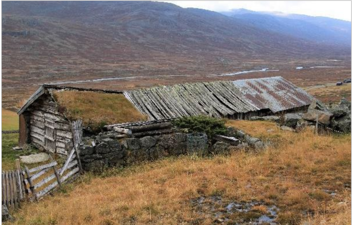
Bilde 26. 2020. På Enersvolds seter i Smørليا var det vintersetring på 1130 meters høyde. Fjøset har fire rom. Det er bygd om, men har rester etter et eldre trevfjøs. Et bredt murfundament løper ca. 1 meter fra langveggen, med deler av kjørebri til et trev over midtrommene. Foto Kari Stensgaard, NIBIO.
