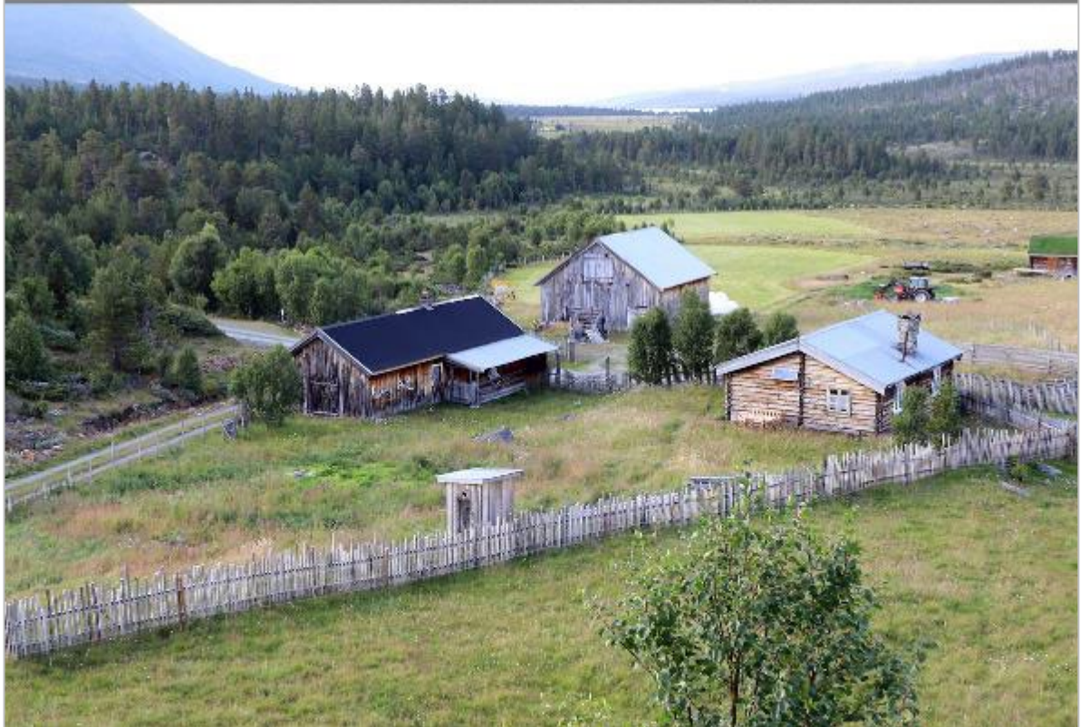
Bilde 60. 1970 - 2020. På Lyens seter på Fuglseter er det gamle fjøset nylig revet og ryddet vekk. Foto Arthur Sand, UiO og Oskar Puschmann, NIBIO.
