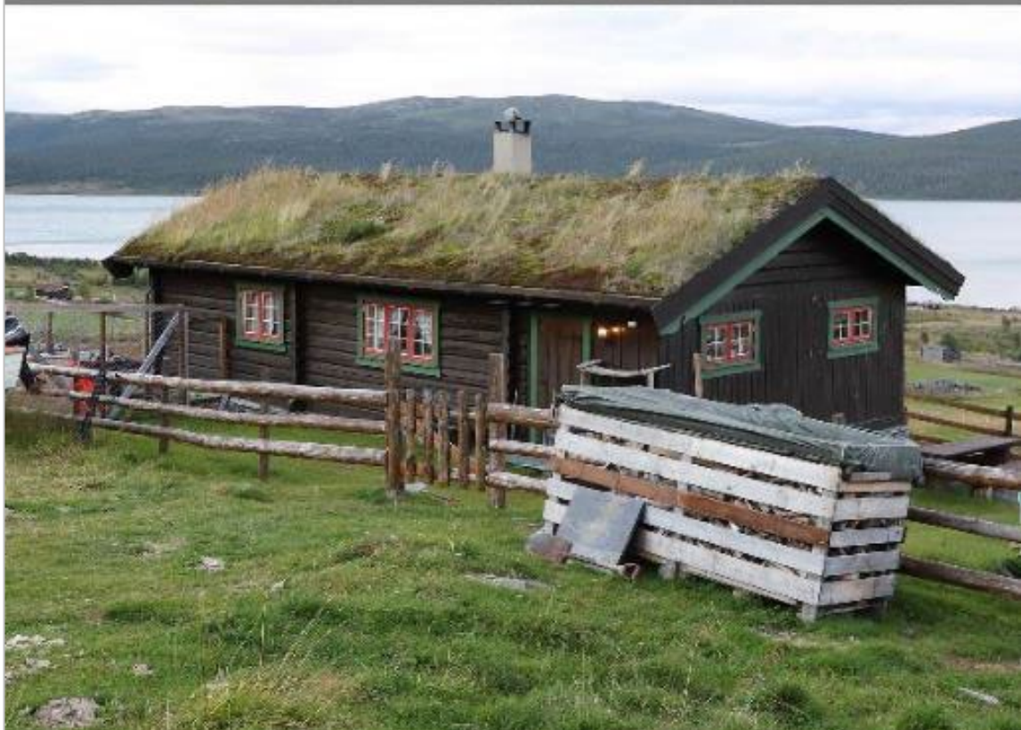
Bilde 49. 1970 - 2020. Stua på Bruøygard hadde skut i reisverk, litt lavere og smalere enn selve tømmerstua. Stuer med slik konstruksjon var det tidligere flere av ved Tesse. Huset var i dårlig forfatning, og ble seinere erstattet av et nytt bygg med lik hovedform. Foto Arthur Sand, UiO og Oskar Puschmann, NIBIO.
