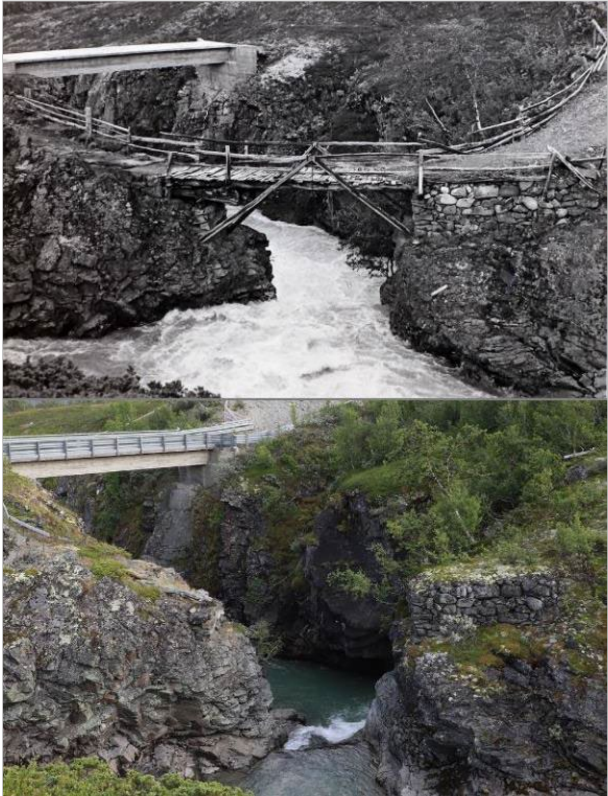
Bilde 5. 1970-2020. Forbindelsen mellom sørlig og vestlig del av sjøen har vært utfordrende. Spesielt var forsering av elva Smådøla vanskelig. I 1970 var arbeidet med ny bro i gang og i 2020 er brua for lengst tatt i bruk. Av den gamle brua ses kun brufundamenter. Foto Arthur Sand, UiO og Oskar Puschmann, NIBIO.
