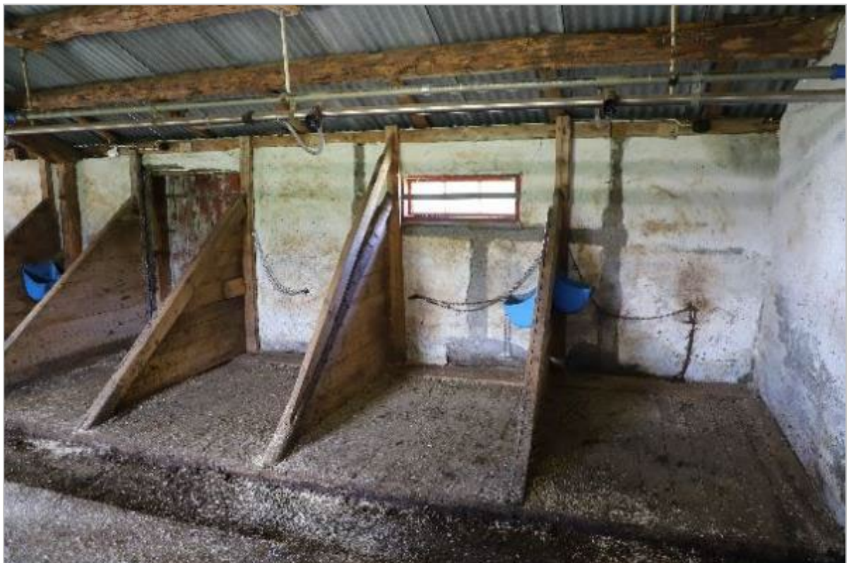
Bilde 29. 2020. Merkene i murpussen viser at båsene er blitt utvidet for å passe til større kyr. Her er fire båser blitt til tre. NRF er betydelig større enn de gamle ferasene, og har selv vokst siden avlsarbeidet skjøt fart etter krigen. Lyngvedøygard på Nordseter. Foto Oskar Puschmann, NIBIO.
