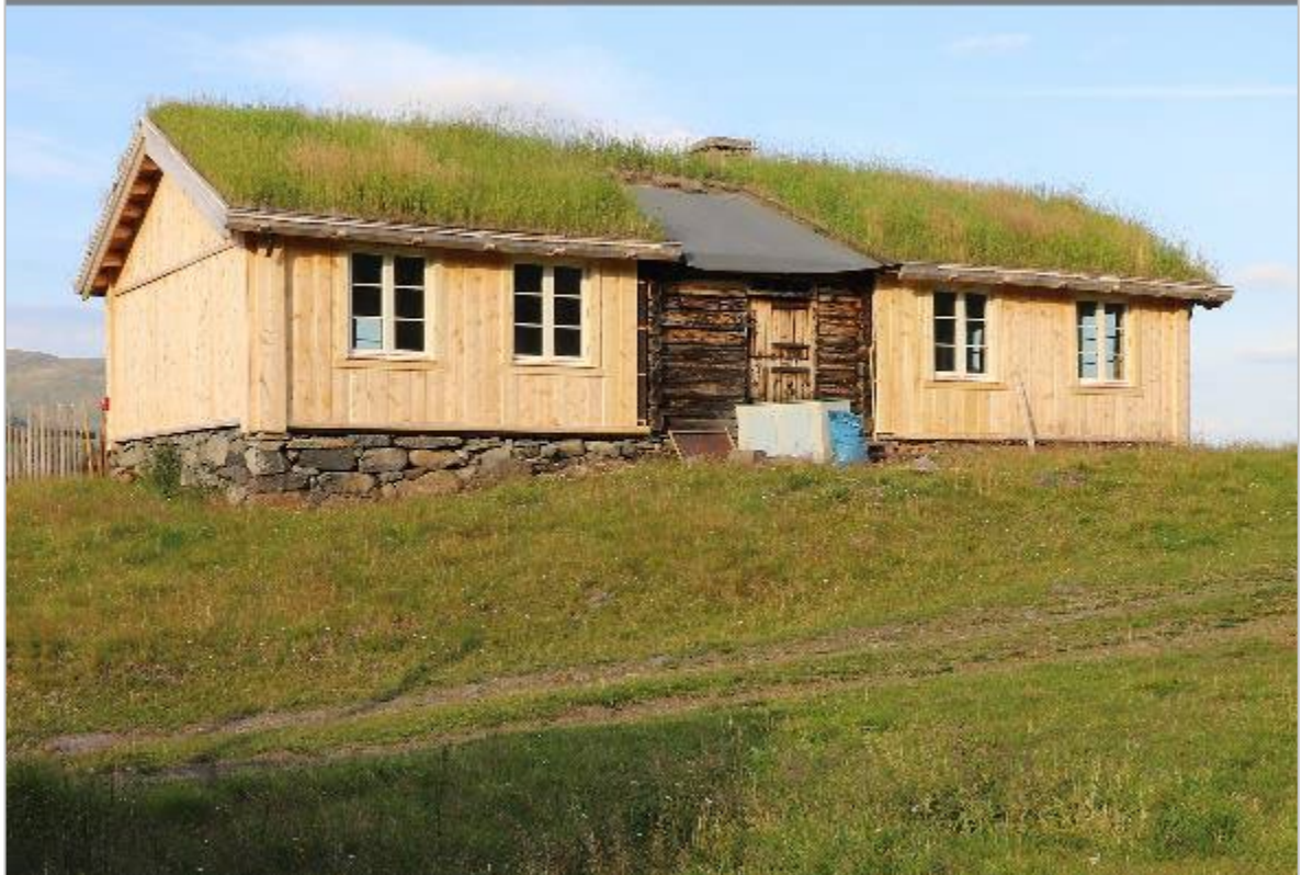
Bilde 50. 1970 - 2020. En fjerdedel av seterstuene ved Tesse har fått fasadeendring etter 1970. Typisk er tømmerveggene panelt inn, som her på Fuglsetra. Foto Arthur Sand, UiO og Oskar Puschmann, NIBIO.
