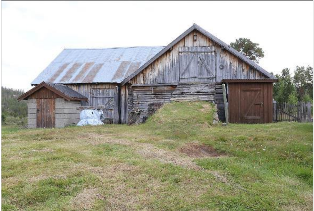
Bilde 62. 1970 - 2020. En driftsbygning med rom for dyr, fôr og redskap under samme tak ble satt opp på Skogly i 1920-åra. I 1970 var laftefjøsset med høytrev i god stand, mens løa i reisverk var nedslitt. Geitfjøsset i reisverk, som sto på høyre side av fjøsset, ble siden fjernet. Foto Arthur Sand, UiO og Oskar Puschmann, NIBIO.
