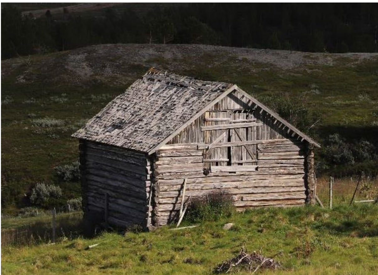
Bilde 31. 2020. Det siste (synlige) flistaket ved Tesse ligger på Bruøygards tømmerløe på Nåvårseter. Enn så lenge. Foto Oskar Puschmann, NIBIO.
