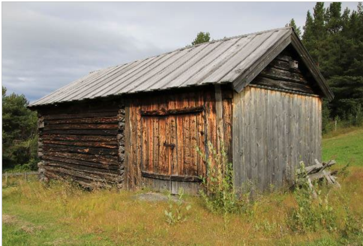
Bilde 30. 2020. Løa på Enden har fått ny bordkledning både på tak og vegger. Foto Kari Stensgaard, NIBIO.
