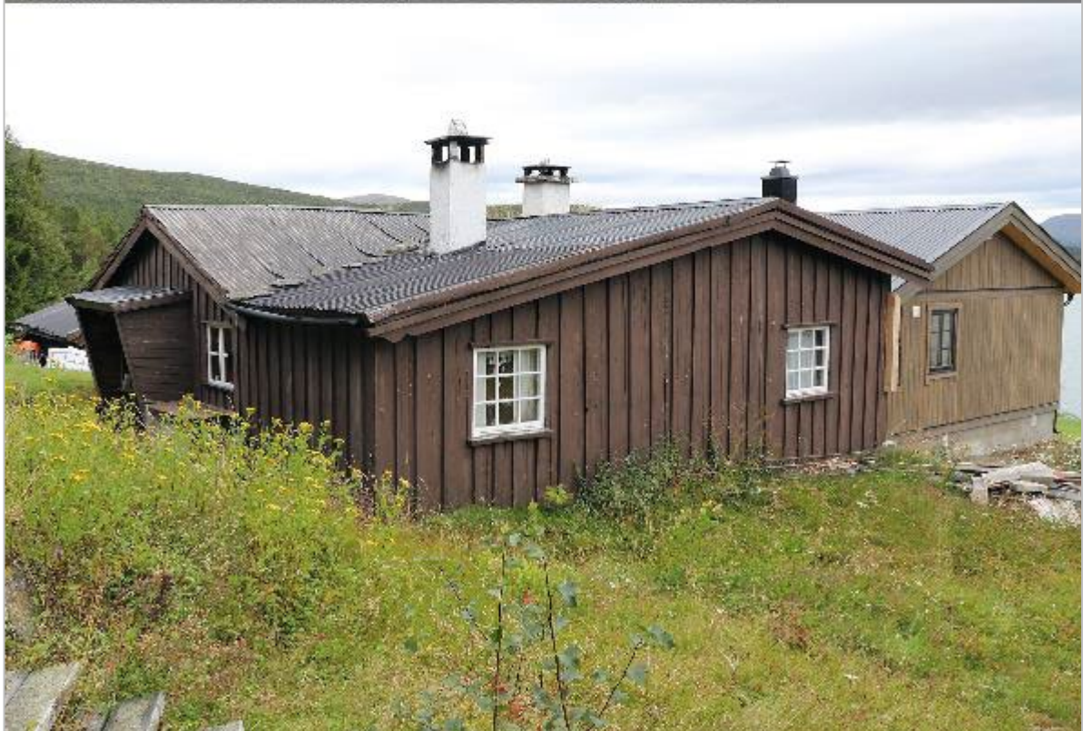
Bilde 52. 1970 - 2020. Stua på Tungsetra i Djupvika har hatt et langt liv med tilpasninger til nye tider. Den gamle laftestua med tilbygg i reisverk fikk seinere et større tilbygg langs hele langsida, og i disse dager er en hytte under oppføring rett nedenfor. Foto Arthur Sand, UiO og Oskar Puschmann, NIBIO.
