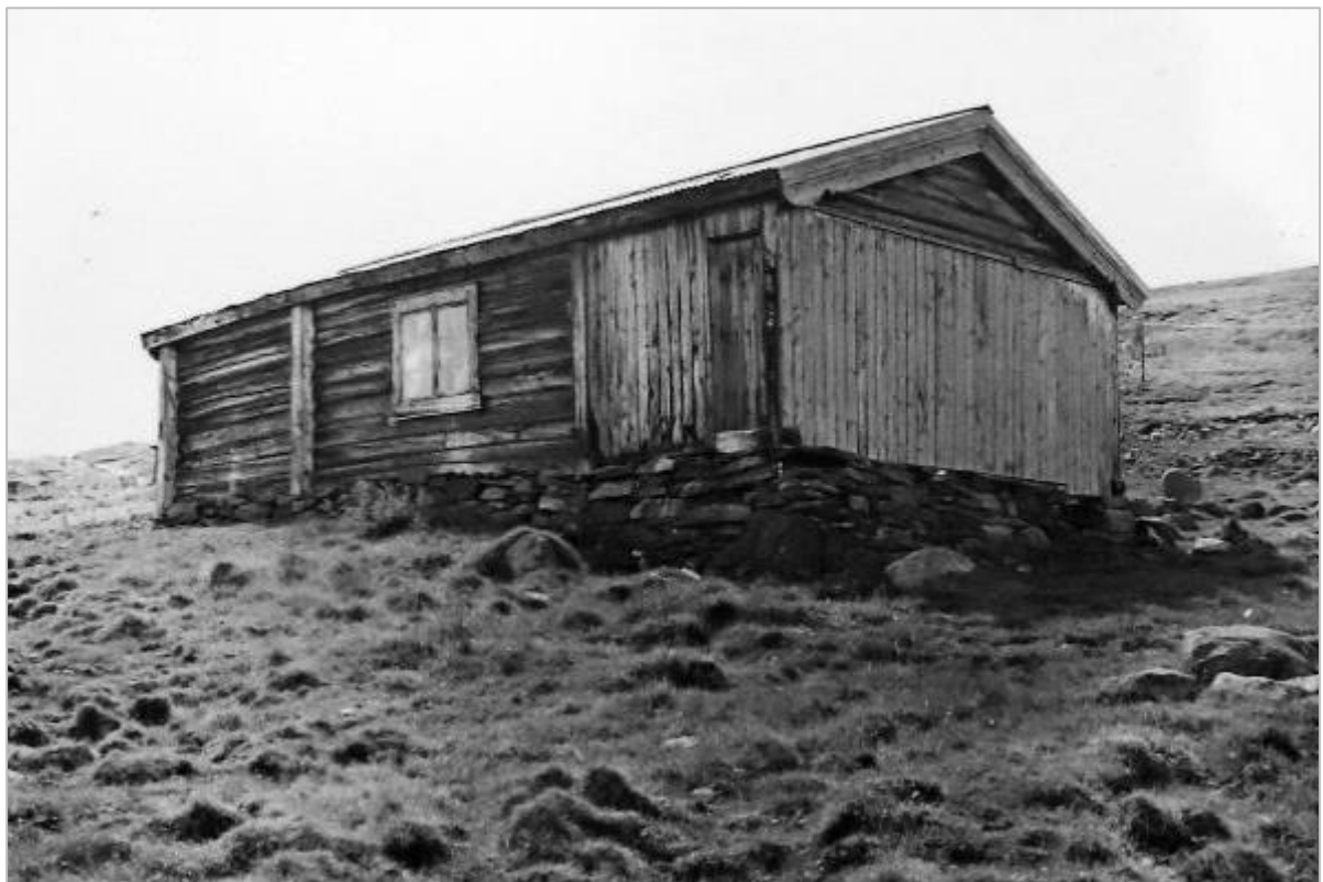
Bilde 12. 1970. Hiems stue på Nåvårseter har også tre rom på rekke. Skuten er i reisverk. Foto Arthur Sand, UiO.
