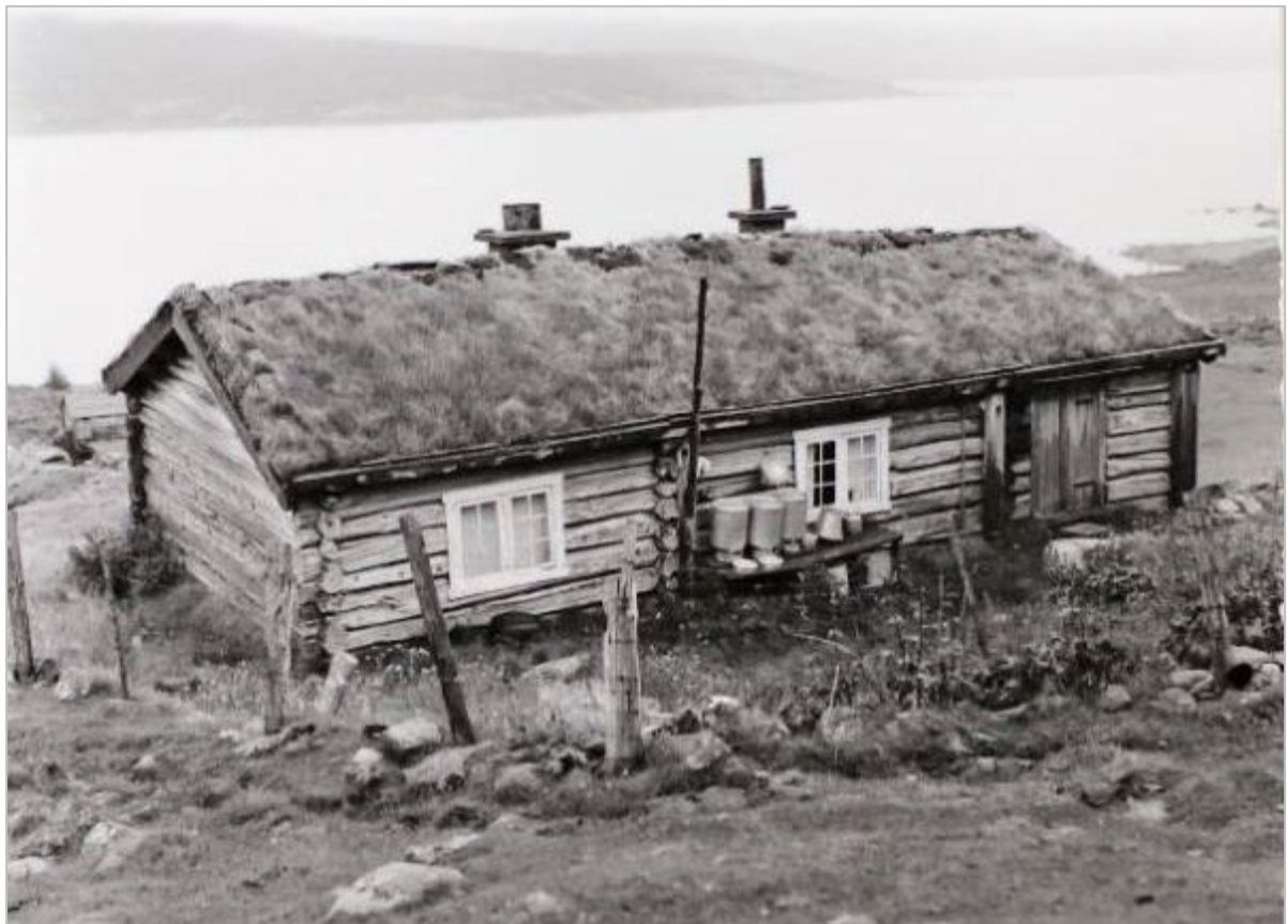
Bilde 11. 1970. Søre Byres stue på Byrtnes har den mest vanlige konstruksjonen med tre tømra rom på rekke. Inngangen er i skuten. Foto Arthur Sand, UiO.
