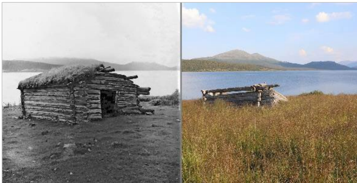
Bilde 41. 1970 - 2020. Løa ligger vakkert til ned mot sjøen. Den har vært ute av bruk lenge og har fått stå og forfalle i fred. Foto Arthur Sand, UiO og Oskar Puschmann, NIBIO.
