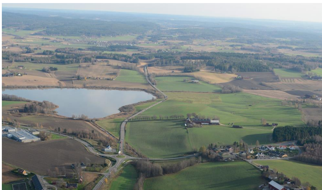
Figur 8.7. Jordflytting er en sentral del av ny E18 Retvedt-Vinterbro. Dette bildet er fra Holstad. Foto: Statens Veivesen.
