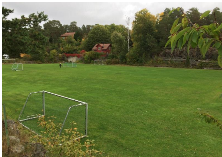
Bilde 6. Banen sett fra sørvest mot nordøst. Dårlig drenert område under muren foran det røde huset i motsatt hjørne. Langs hele østre langsida og spesielt i dette hjørnet kan det være et problem at overflatevann kommer inn på banen fra det høyere terrenget i bakkant.
