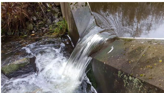
Figur 2. V-overløpet som ble anlagt i Kolstadbekken i 2012. Foto: NIBIO.
