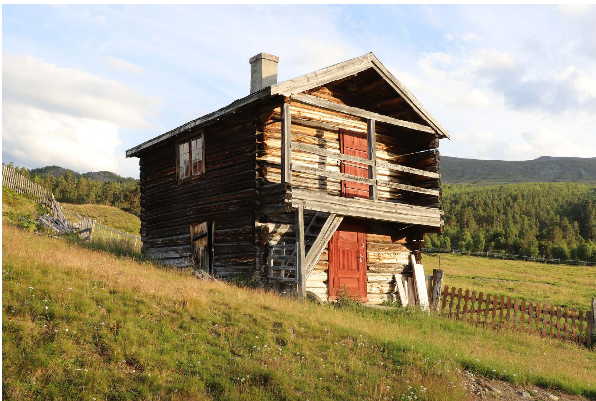
Et eksempel på en SEFRAK-registrert bygning i jordbrukslandskapet. Foto: Oskar Puschmann / NIBIO.
