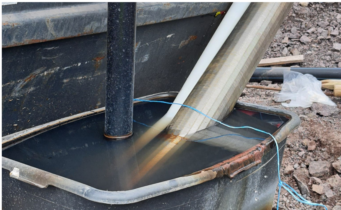
Figur 8. Utløpskar for rensert vann instrumentert med nitrat- og multiparametersensor (Foto: Elise M. Sverdrup).
