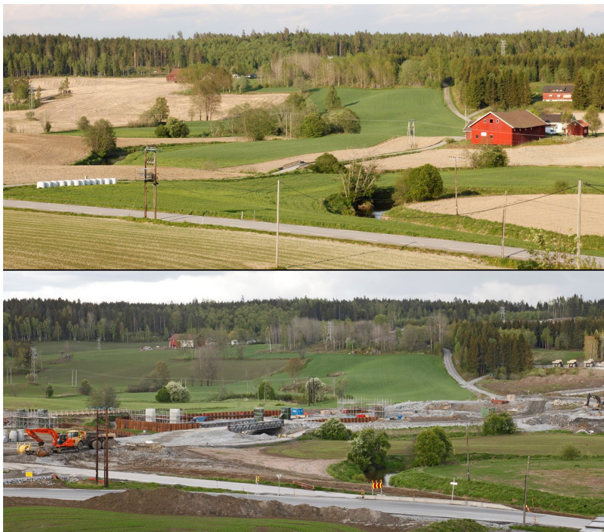
Figur 12: Bygging av ny europavei over jordbruksareal i Hobøl kommune, Østfold (2012 og 2015). Foto: Oskar Puschmann / NIBIO.
