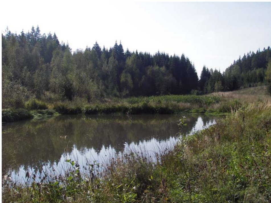
Bilde 5: Lundem-dammen sett fra sedimentasjonskammeret og nedover.
