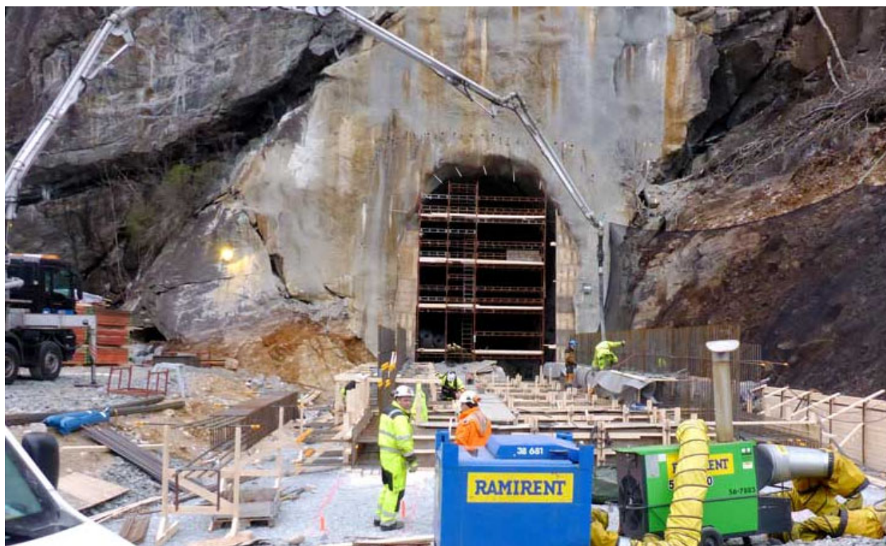
Figur 1. Påhugg for tunnel til ny fjellhall for vannkraftanlegget Lysebotn II
