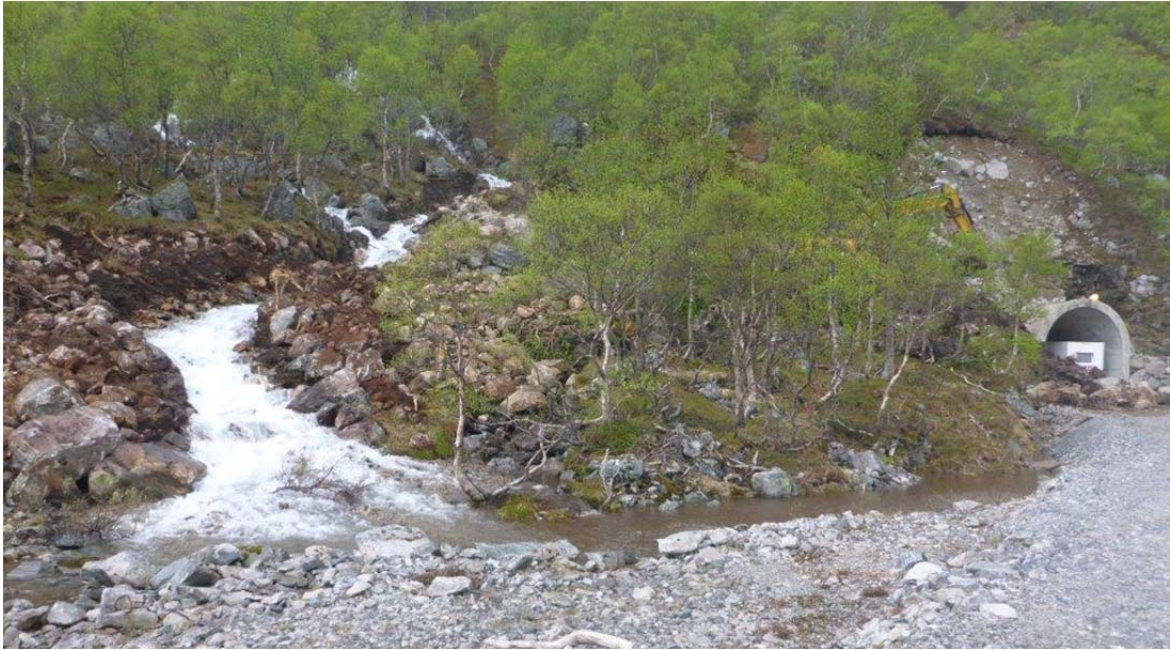
Nytt bekkeleie for bekk ved Strandvatn etablert 20.05.14.
