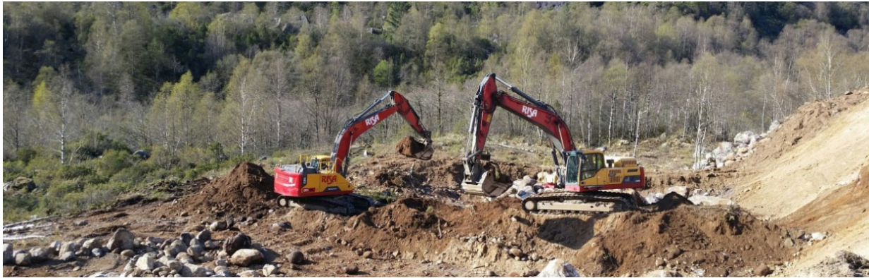
Figur 4. Grave- og fyllingsarbeidene ved Stølsåna, med en buffersone mot elva
