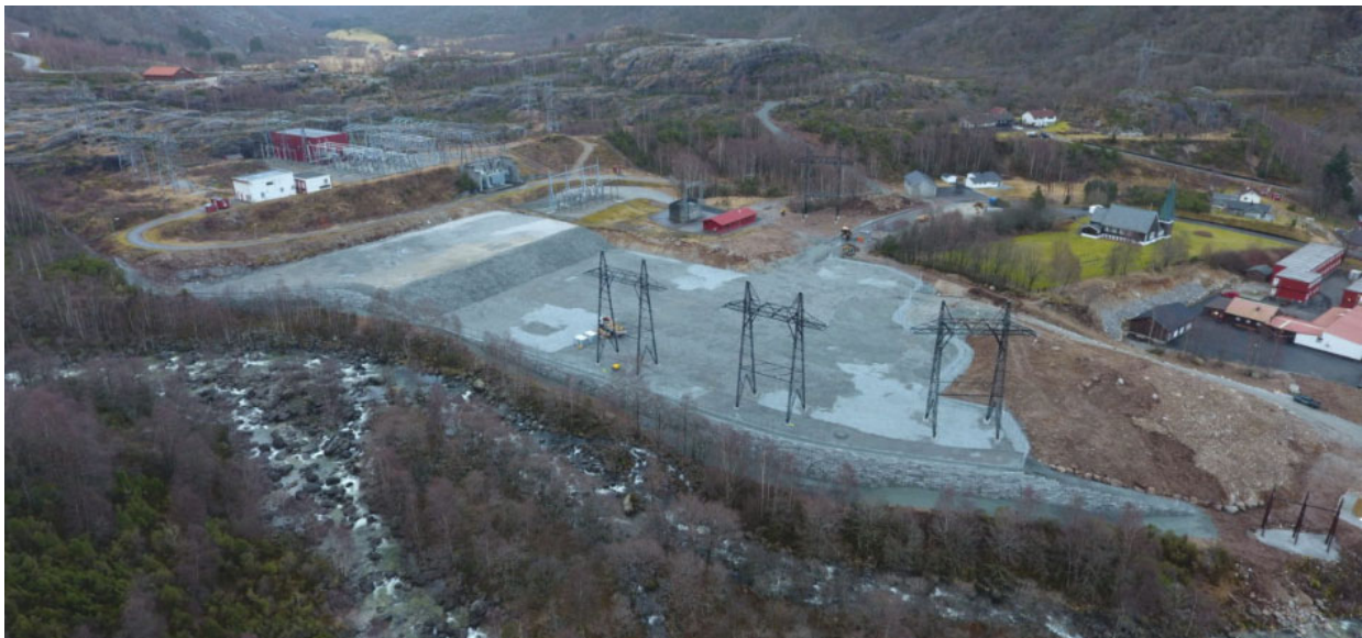
Figur 5. Ferdige grunnarbeider Lyse transformatorstasjon i 2017
