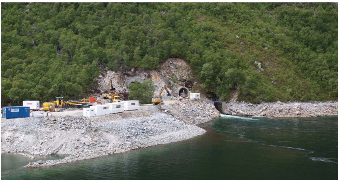
Anleggsområde ved Strandvatn 23. juni 2014.
