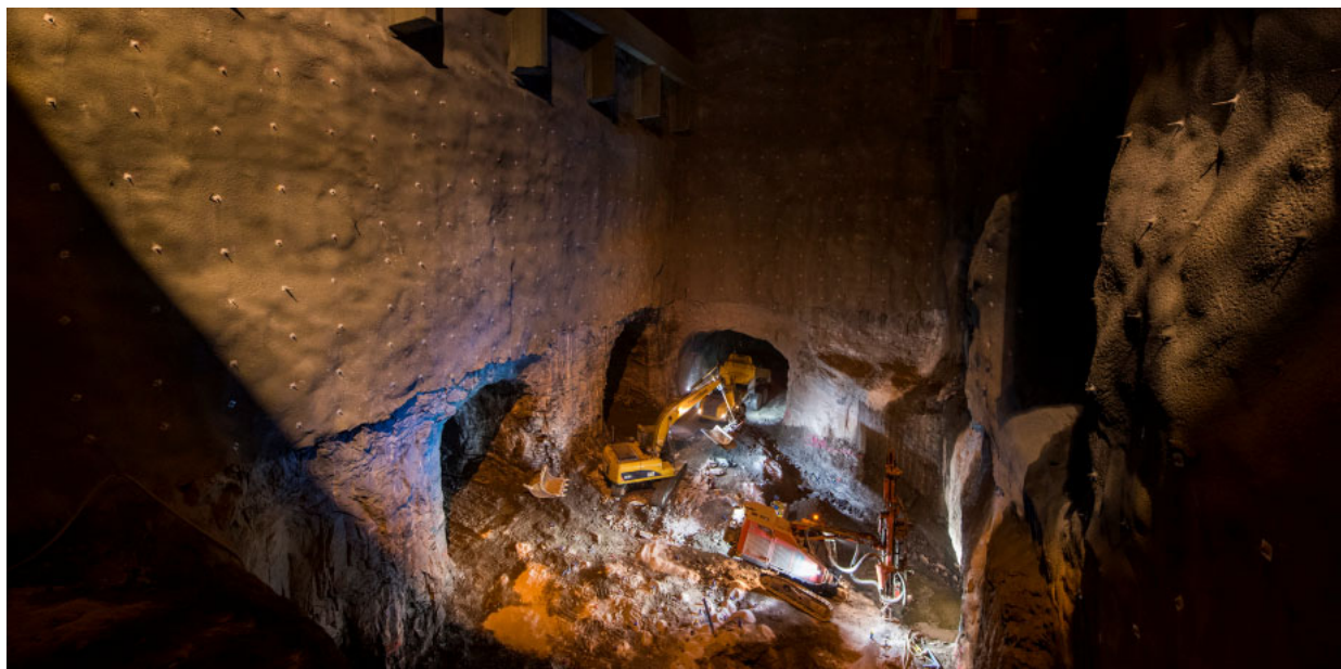
Figur 2. Fjellhall for etablering av ny kraftstasjon, 1500 m inn i fjellet
