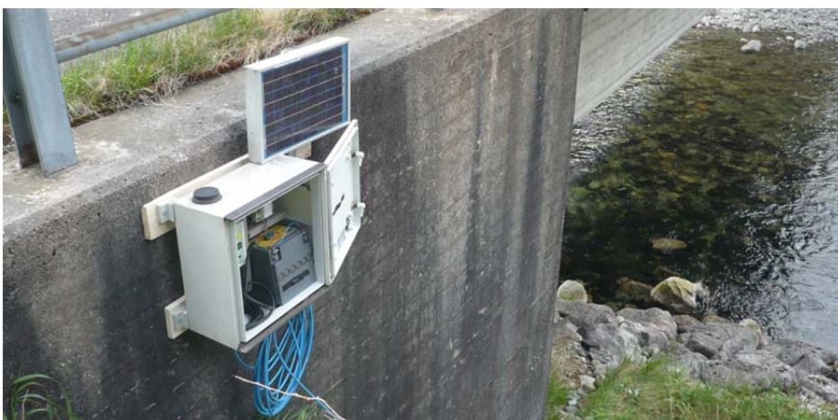
Figur 4. Målestasjonen Lyseåna nedstrøms etter etablering juni 2013.
