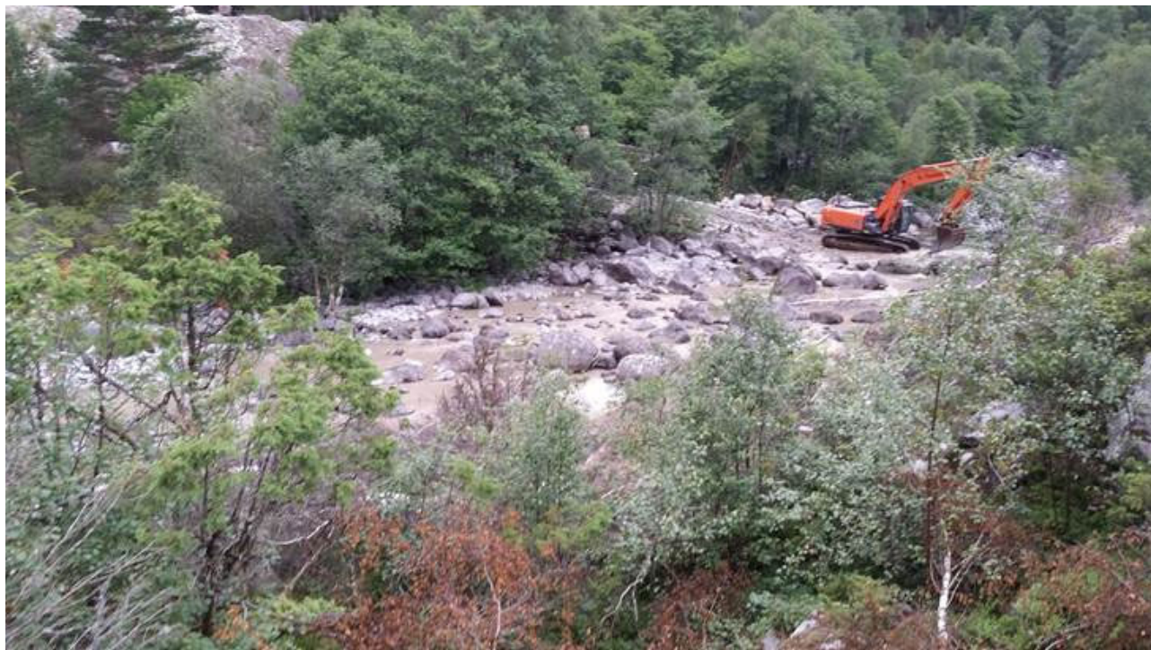
Figur 13. Legging av trekkerør for 420 Kv ledning over Stølsåna, som foregikk i perioden 27.06 til 06.07.16.
