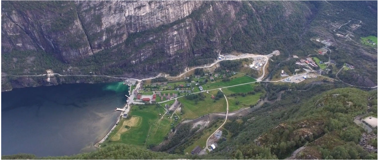
Oversikt over anleggsaktivitet under bygging av Lysebotn II våren 2016
