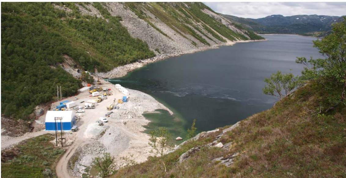
Anleggsområde ved Strandvatn 23. juni 2014.
