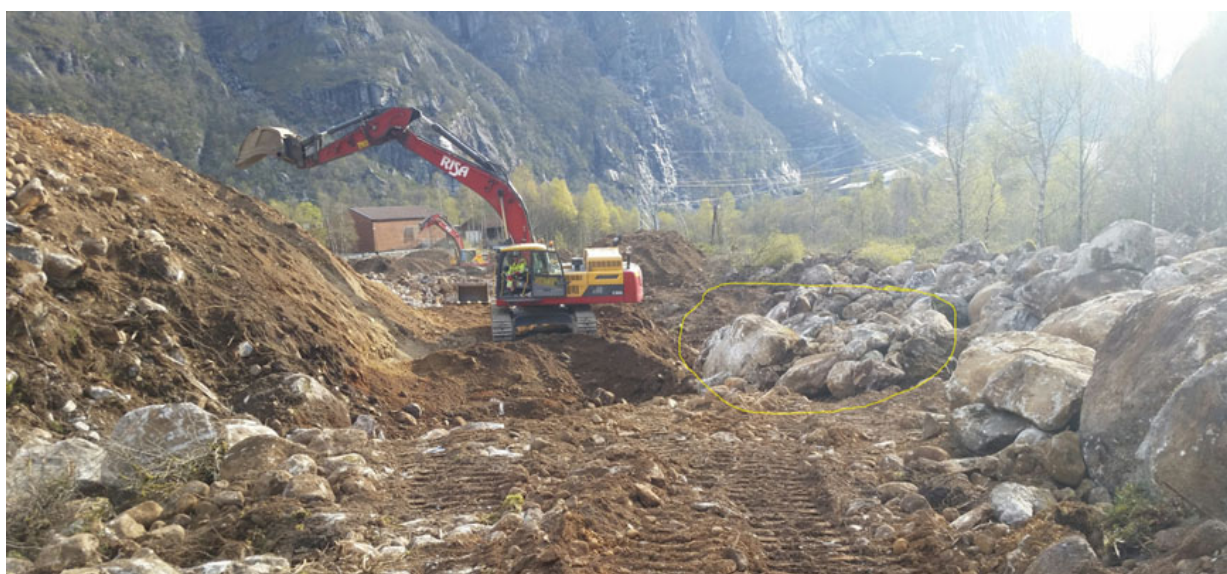
Figur 3. Grunnarbeid for Lyse transformatorstasjon i 2016
