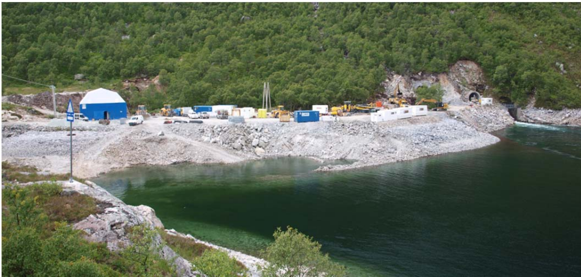
Anleggsområde ved Strandvatn 23. juni 2014.
