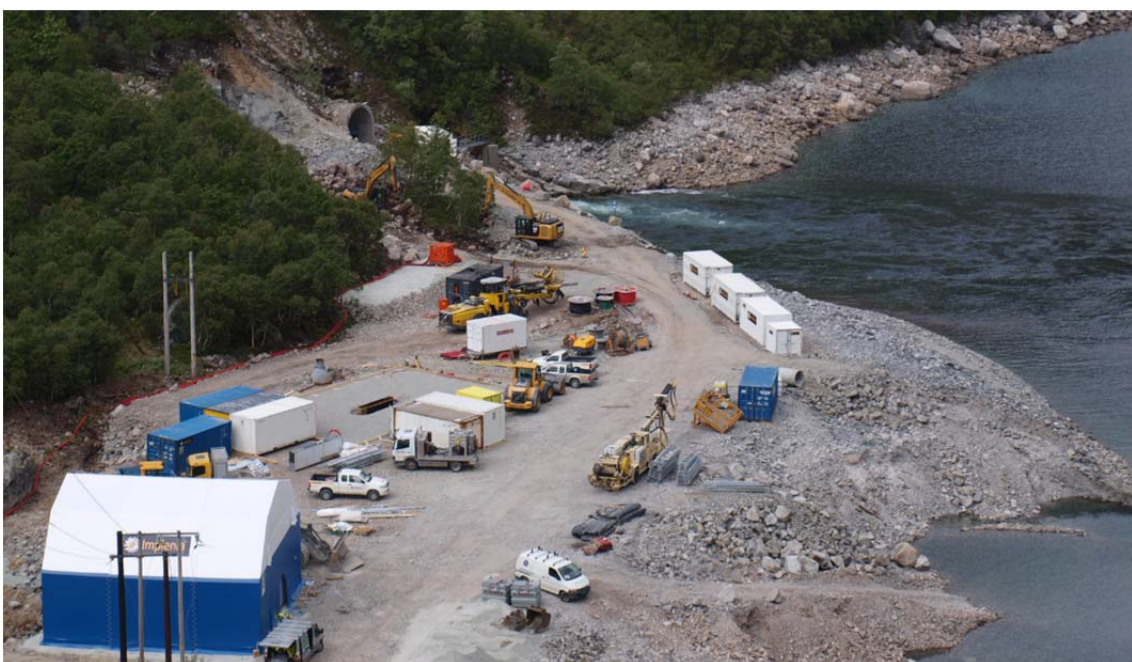
Anleggsområde ved Strandvatn 23. juni 2014.
