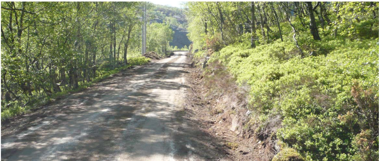
Forbedring av veg mot Strandvatn opp fra Lysebotn, juni 2013.
