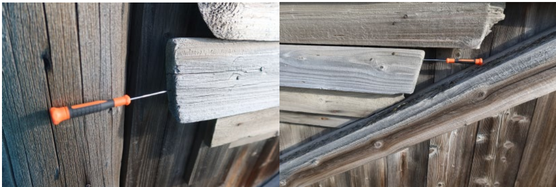
"Taubanestasjonen", 93041-14. West side, awl probing
